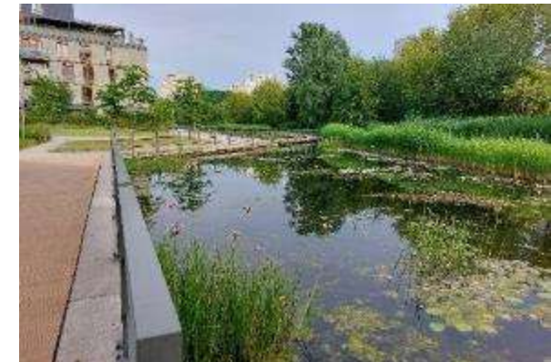
Staw retencyjny na osiedlu Bernardyńska w Warszawie, fot. archiwum E. Walter
