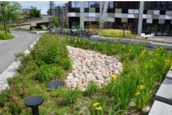
Ogród deszczowy przy budynku biurowym w Oslo, fot. archiwum Instytutu Rozwoju Miast i Regionów
