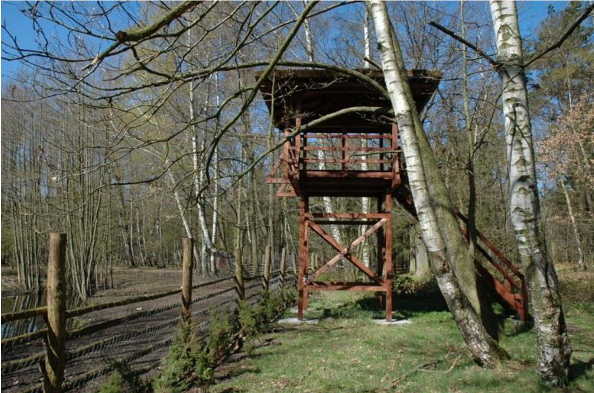
Fotografia 25. Wieża obserwacyjna. Zagroda dzicza w Przebrnie. Archiwum nadleśnictwa
