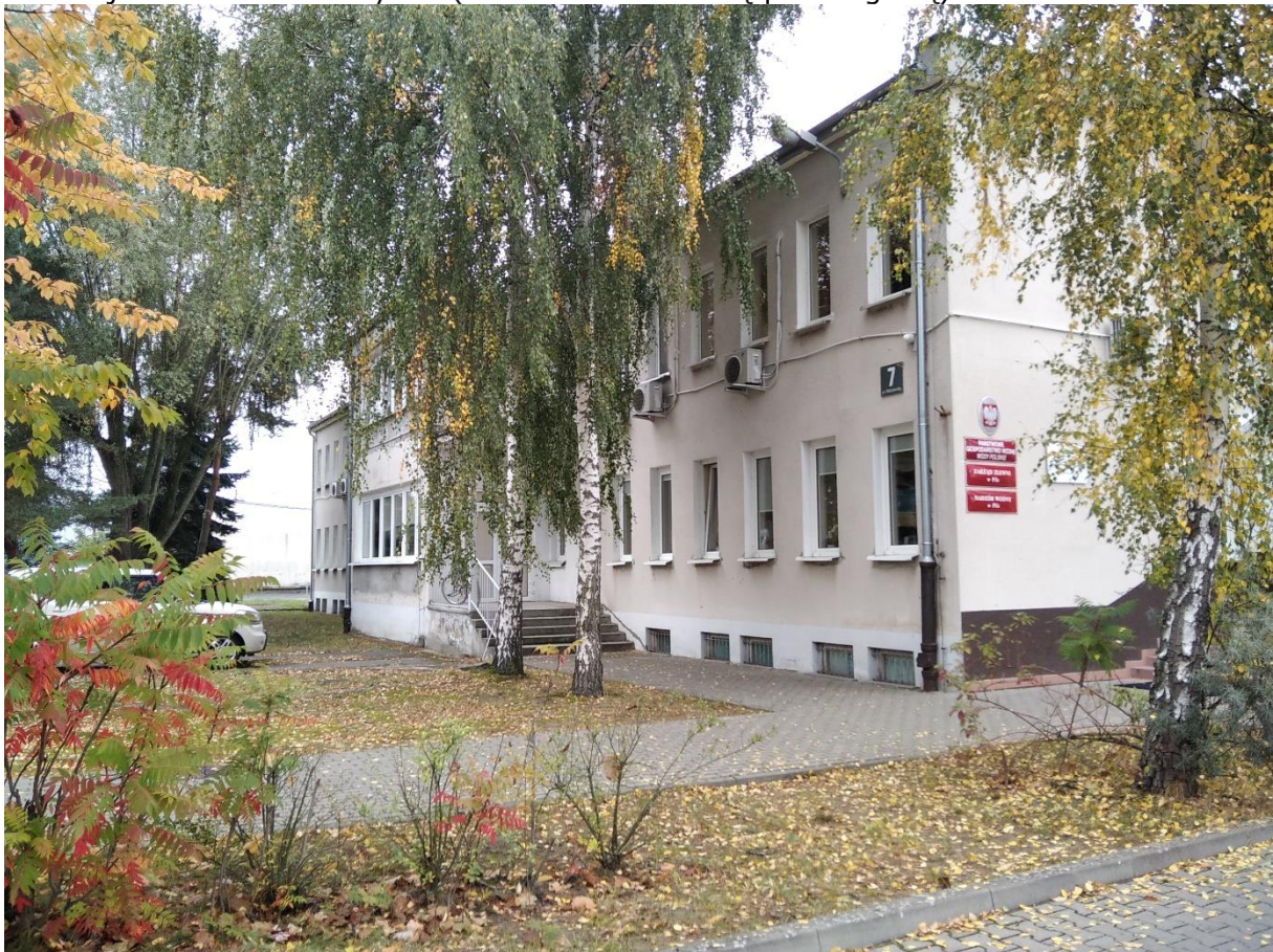
Fot. wejście/wyjście z boku budynku (ewakuacyjne)
