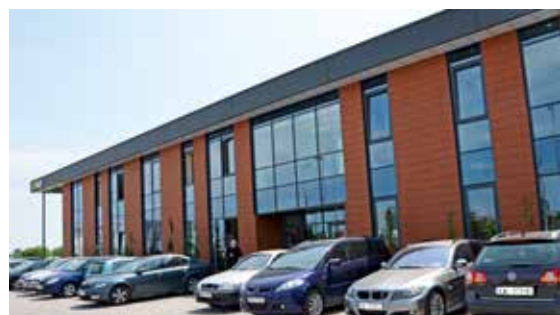
Trefl – fabryka kart zbudowana na gruntach KOWR
