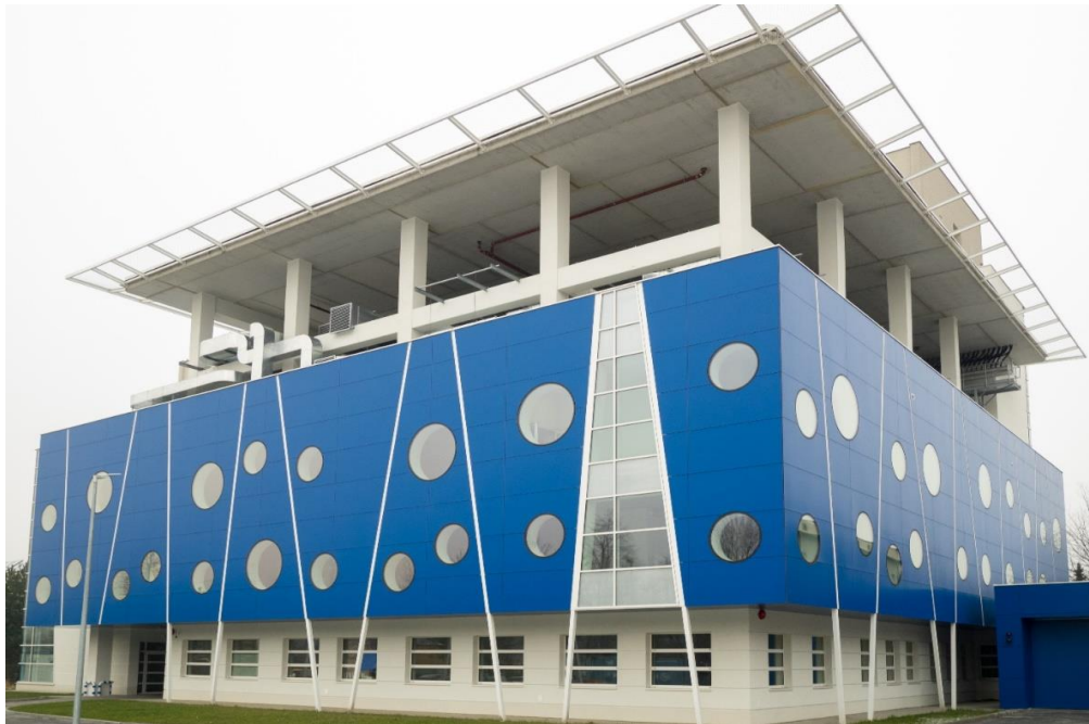
Nowy budynek Samodzielnego Publicznego Górnośląskiego Centrum Medycznego im. prof. Leszka Gieca SUM w Katowicach ul. Ziolowa 45/47 (Źródło: z zasobów szpitala)
