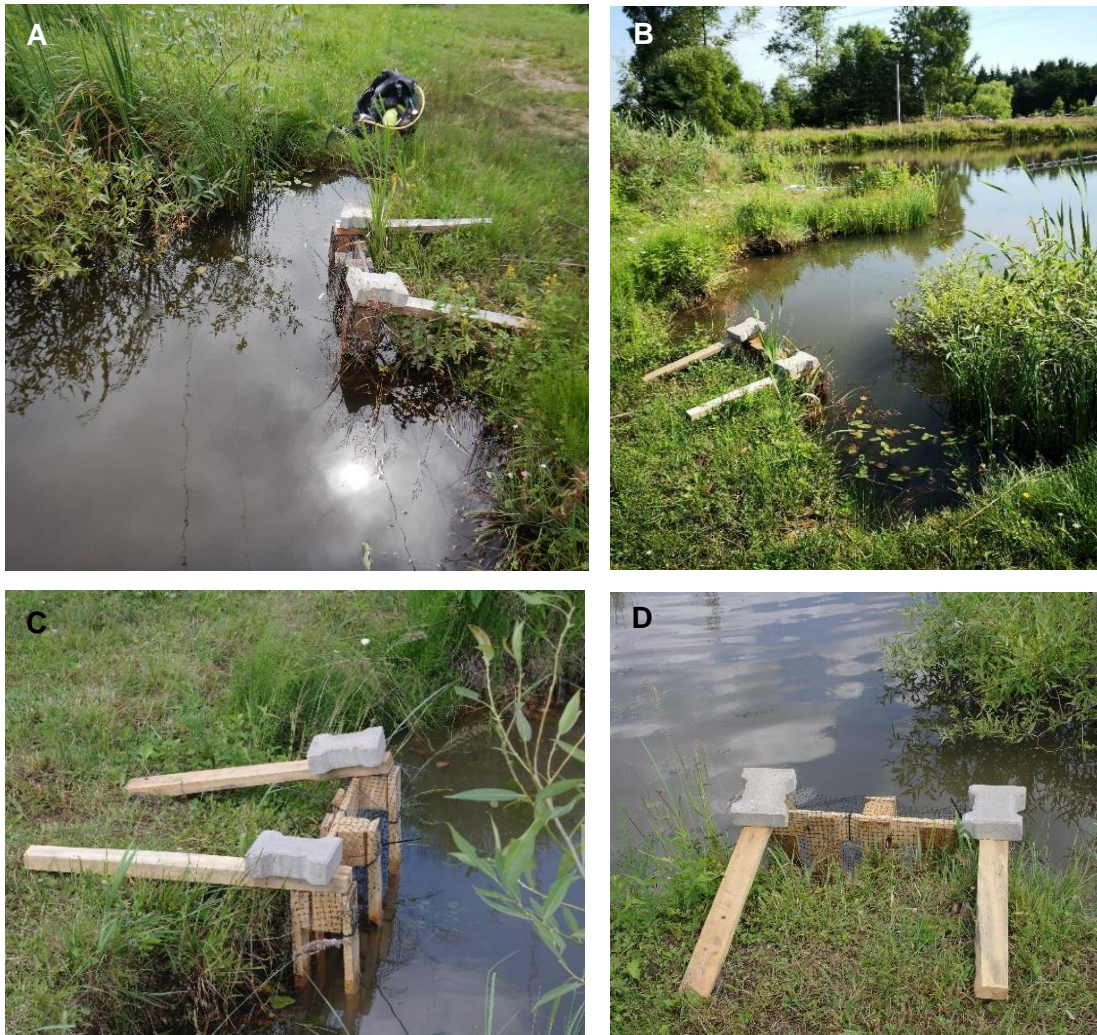
Fotografia 13A-D. Sposób zabezpieczenia odpływów ze zbiornika przed wydostaniem się fragmentów zwalczanego gatunku (fot. A, C, D – M. Gąbka, B. – Ł. Bryl).
