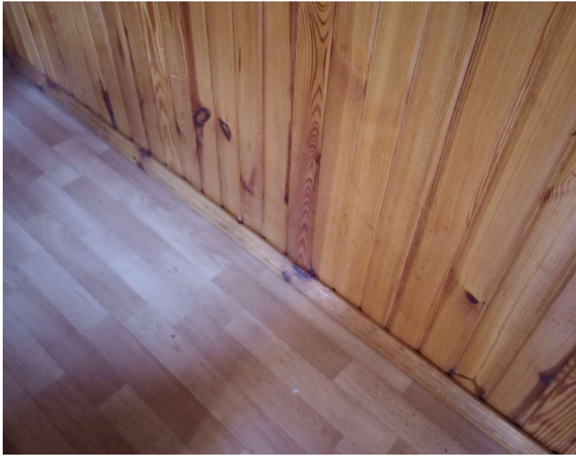
Fot. 1 Pomieszczenie kancelarii – istniejąca okładzina podłogowa PCV
