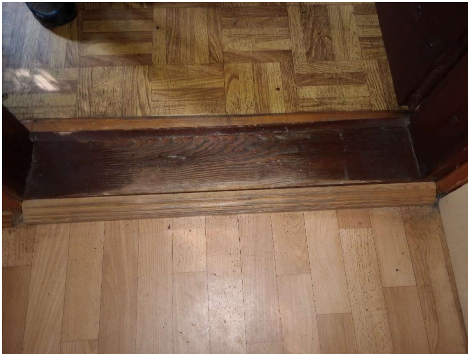
Fot. 4 Pomieszczenie kancelarii i przedśionek kancelarii – istniejące okładziny podłogowe PCV (próg drzwiowy drewniany)
