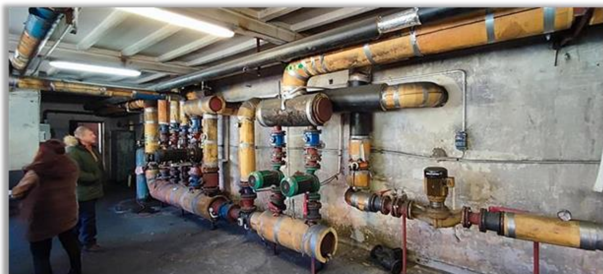
Rysunek 11 Węzeł istniejącej kotłowni
