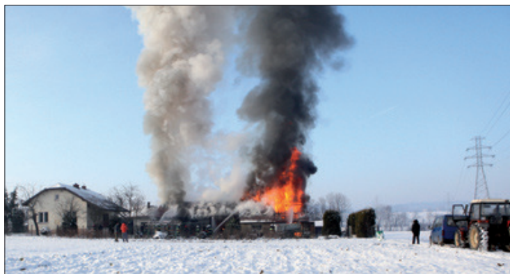
◆ Pożar budynku gospodarczego w Mszance; 2012 rok.
