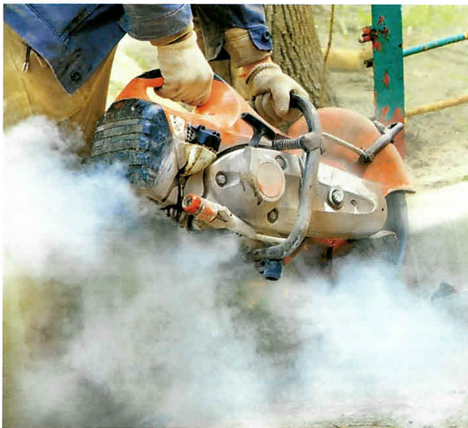
Cięcie betonu – przykład procesu, w trakcie którego może się uwalniać FRKK (fot. photosergii/Bigstockphoto) Cutting concrete – an example of a process during which RCS may be released (photo: photosergii/Bigstockphoto)
