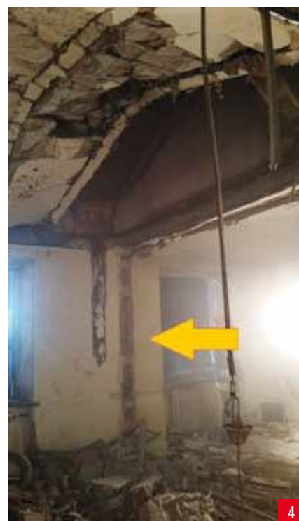
2 i 3. Zniszczenia stropów w pomieszczeniu, w którym prawdopodobnie miał miejsce wybuch. Z prawej zaznaczono linie wskazujące, gdzie znajdował się strop przed wybuchem
