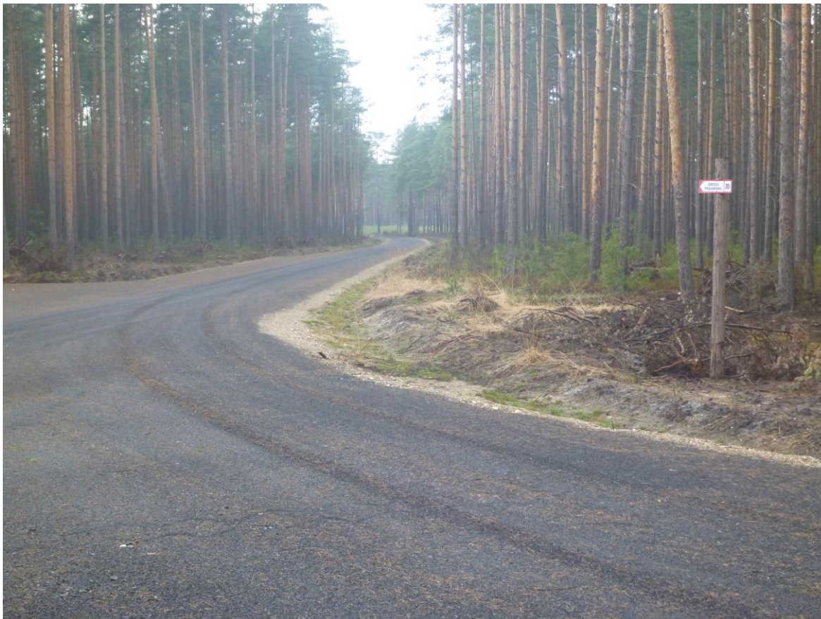
FOT. 3. PRZYKŁAD WYREMONTOWANEJ LEŚNEJ DROGI /FOT. W.DEMPNIAK/
