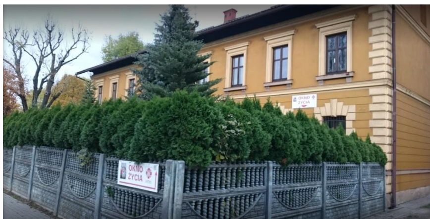
Rys. 16. Dom Samotnej Matki w Rzeszowie przy ul. Ks. Sondejka.
