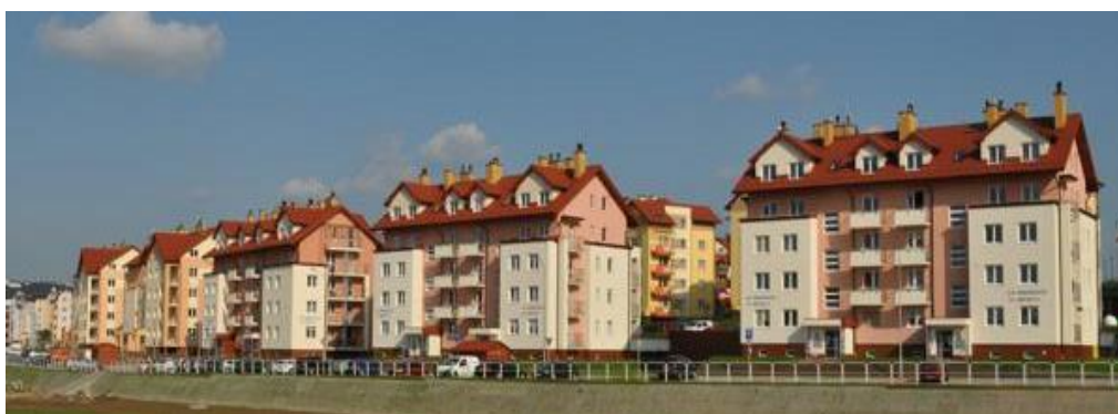
Rys. 29. Zabudowa wielorodzinna na osiedlu Słoneczny Stok w Rzeszowie.
