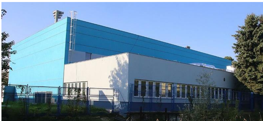
Rys. 21. Hala sportowa na stadionie Miejskim w Rzeszowie.
