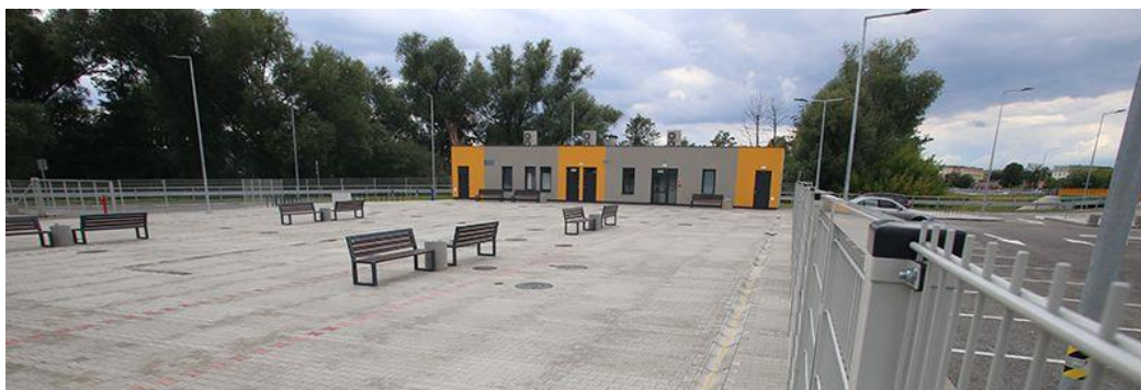
Rys. 15. Plac targowy z ustępem przy ul. Dworaka w Rzeszowie.
