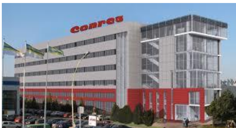
Rys. 28. Rozbudowa budynku CONRES przy Alei T. Rejtana w Rzeszowie.
