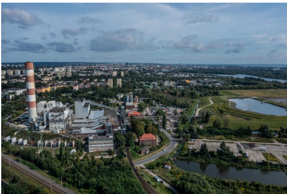
Fot.3 Elektrociepłownia Pomorzany wraz ze składowiskiem. Materiały własne.
