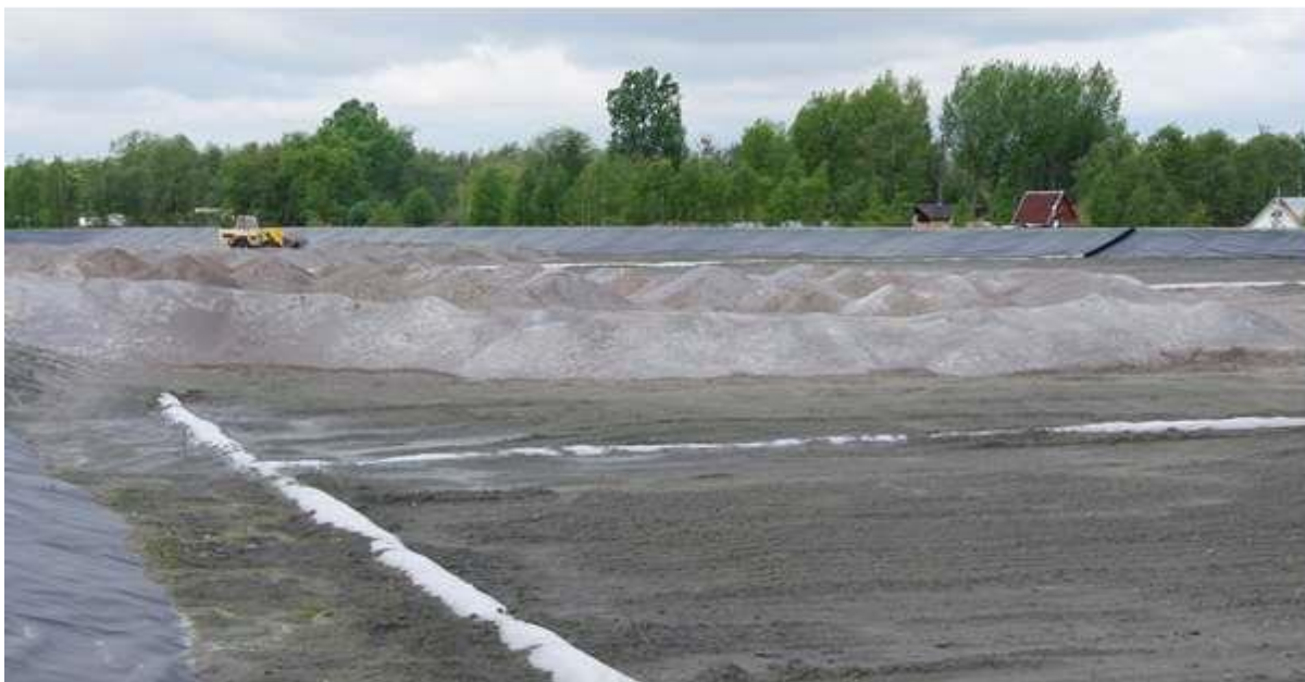
Fot.2 Składowisko odpadów Elektrociepłowni Szczecin. Materiały własne.
