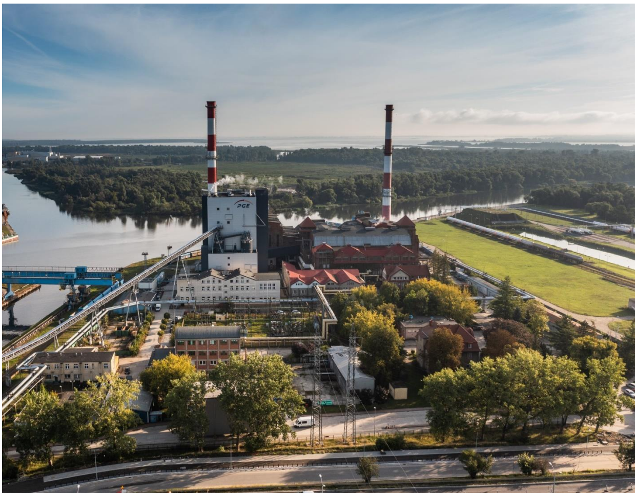
Fot.1 Elektrociepłownia Szczecin. Materiały własne.
