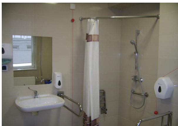
Zdjęcie: Badania wody ciepłej w kierunku bakterii Legionella sp. – natrysk w szpitalu..
