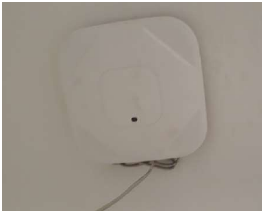
Fot. 1: Widok punktu dostępowego model AIR-CAP1602I-E-K9
