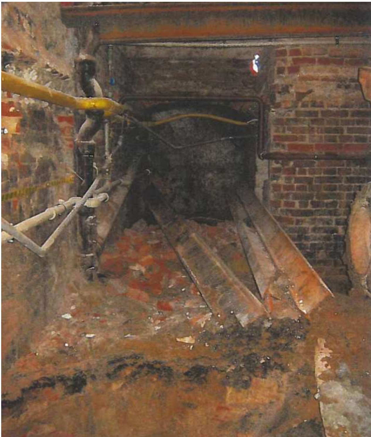
Zdjęcie nr 25 i 26, podkopianie łąw fundamentowych
