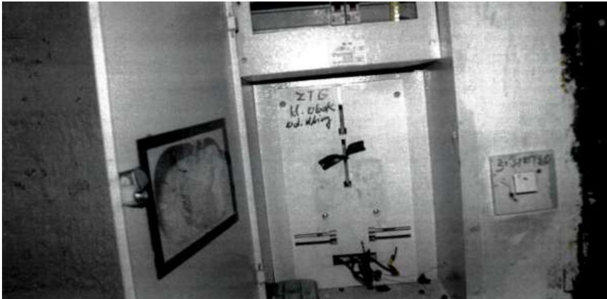
Zdjęcie nr 13, odłączanie liczników
