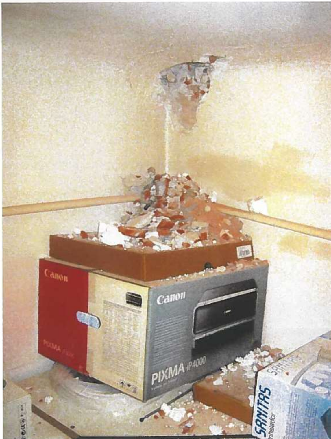
Zdjęcie nr 3, przewiercenie stropu i powstanie dziury w suficie
