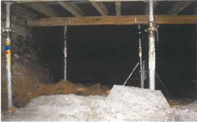
Podparte belki podłogowe (legary) po całkowitym wyburzeniu ścian piwnicznych i stropów
