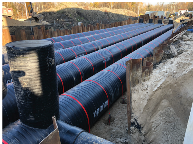
Budowa kanalizacji deszczowej
