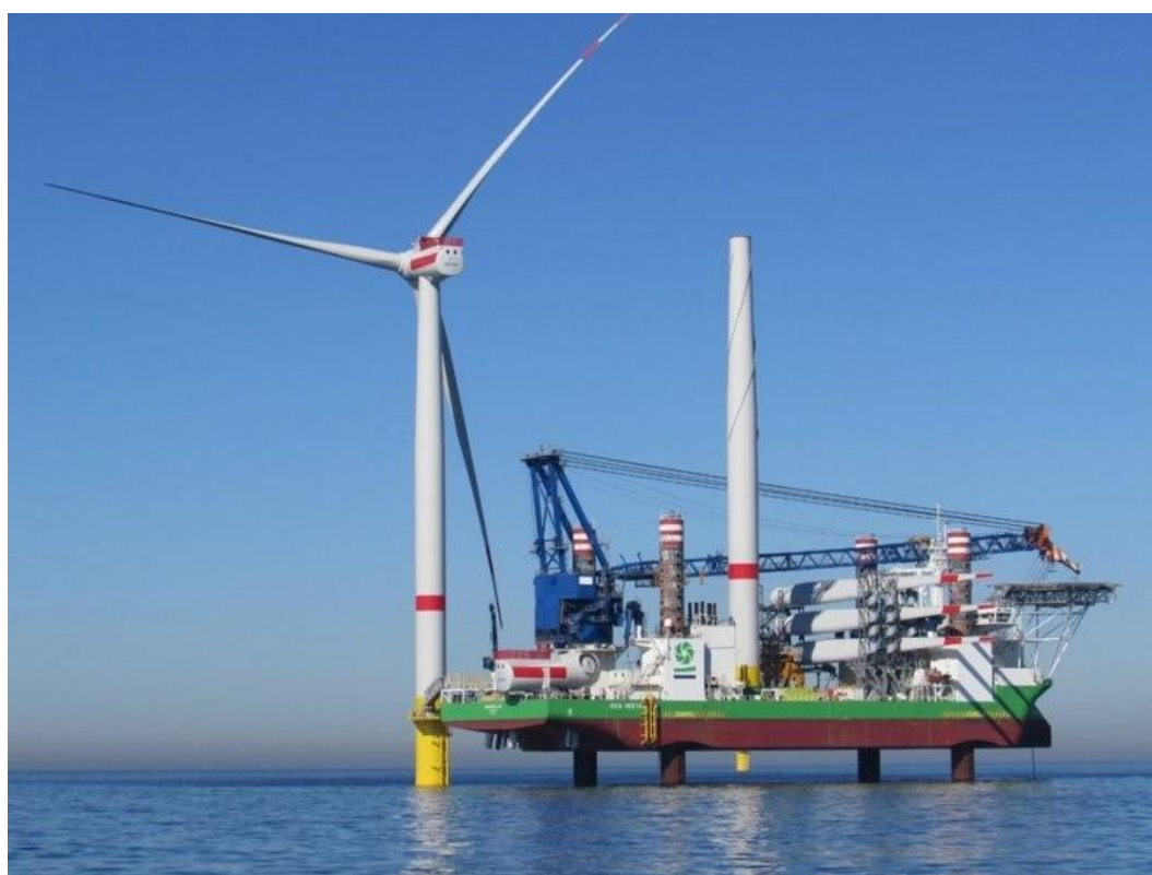
Rysunek 7. Montaż turbin wiatrowych przy użyciu statku typu jack-up. Źródło: COWI
