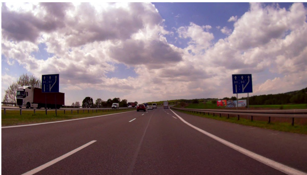
Zdjęcie 1: Początek pasa ruchu powolnego na autostradzie A4 ( Balice I – Rudno , kier. Katowice )
