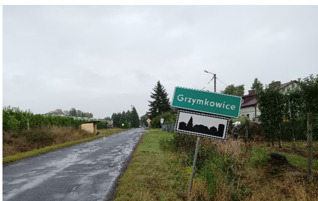
Zdjęcie nr 3 – konstrukcja wsporcza znaku przekrzywiona w stronę rowu
