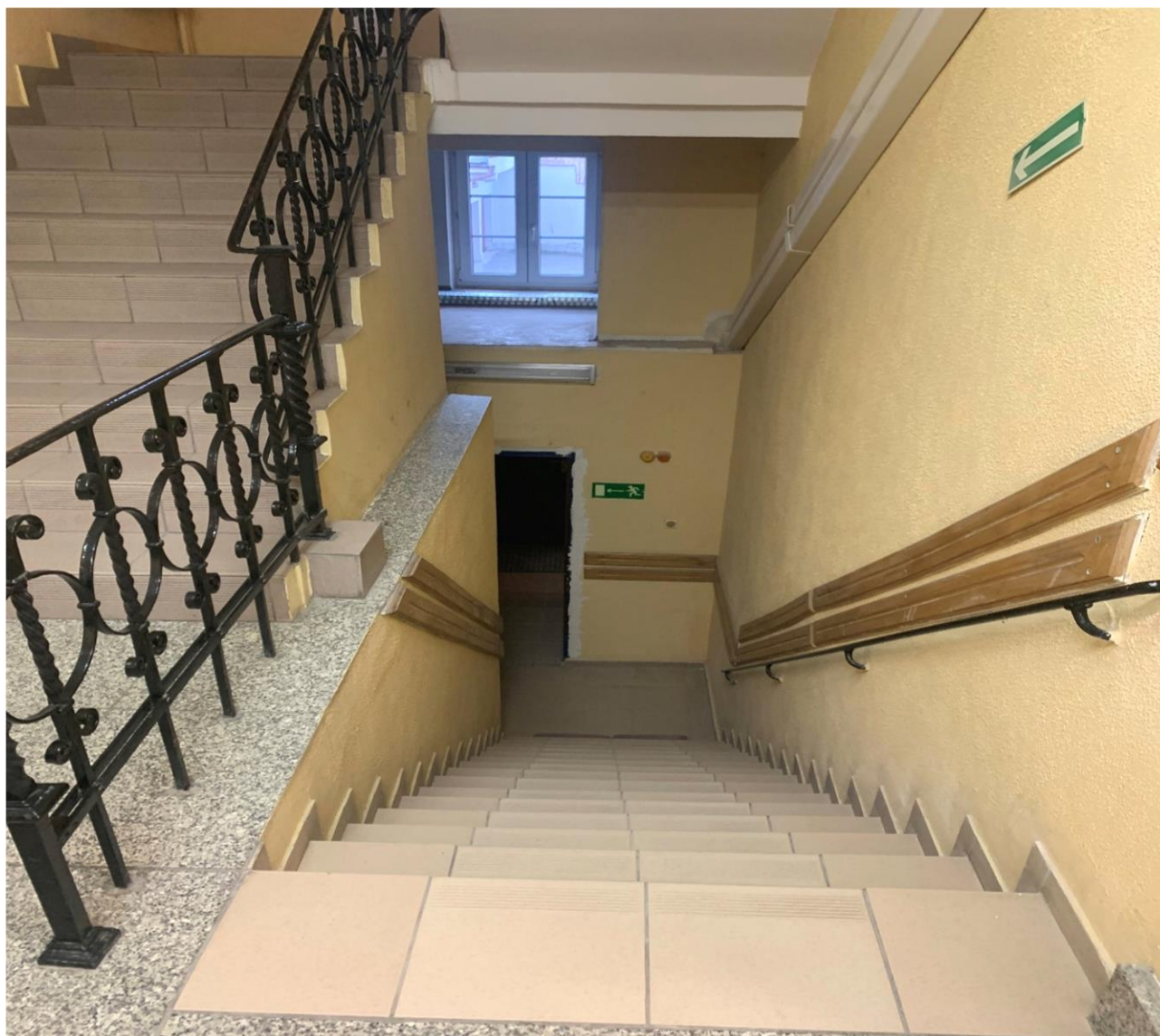
Zdj. 4. Droga do wyjścia ewakuacyjnego z poziomu POK
