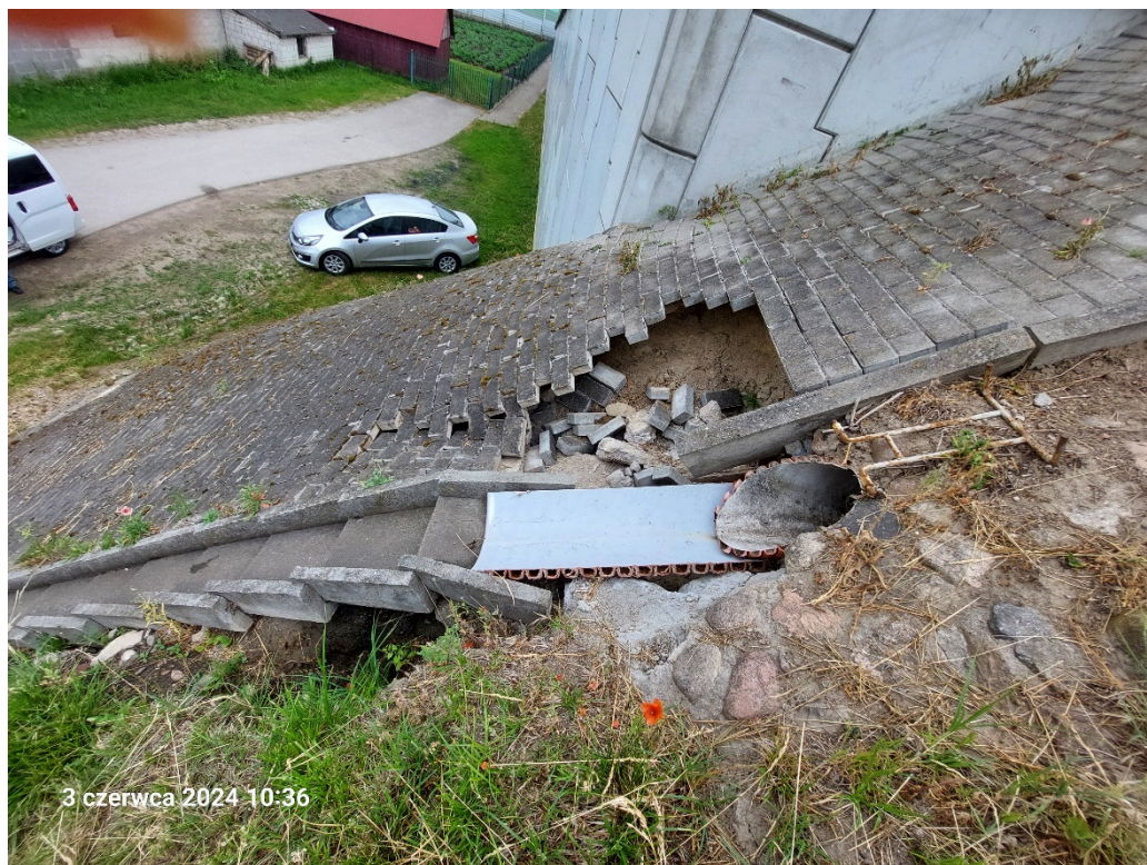
Fot. 3 – Uszkodzona skarpa.
