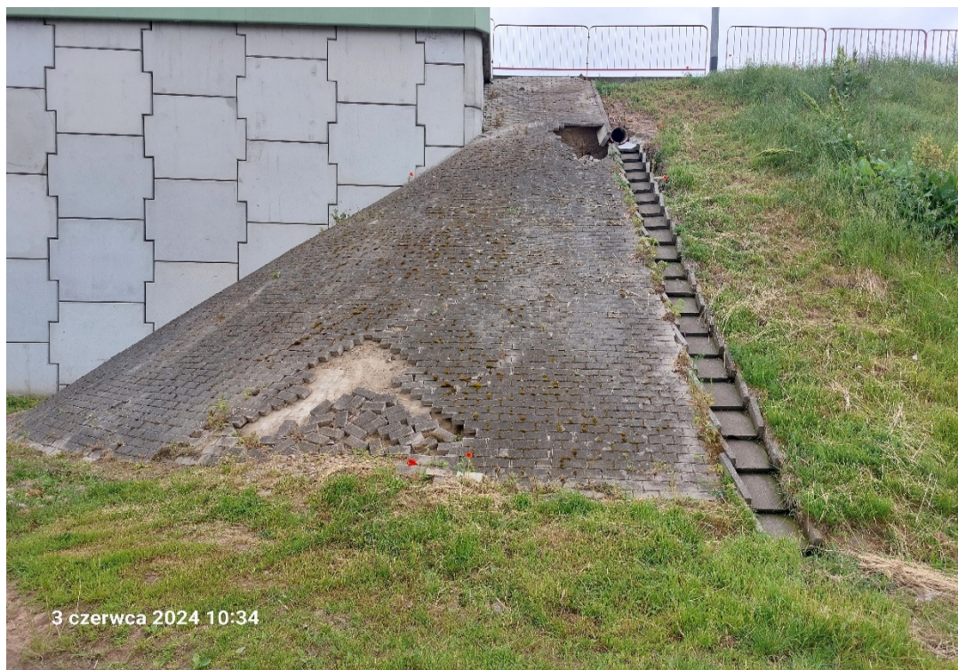
Fot. 1. – Uszkodzona skarpa.
