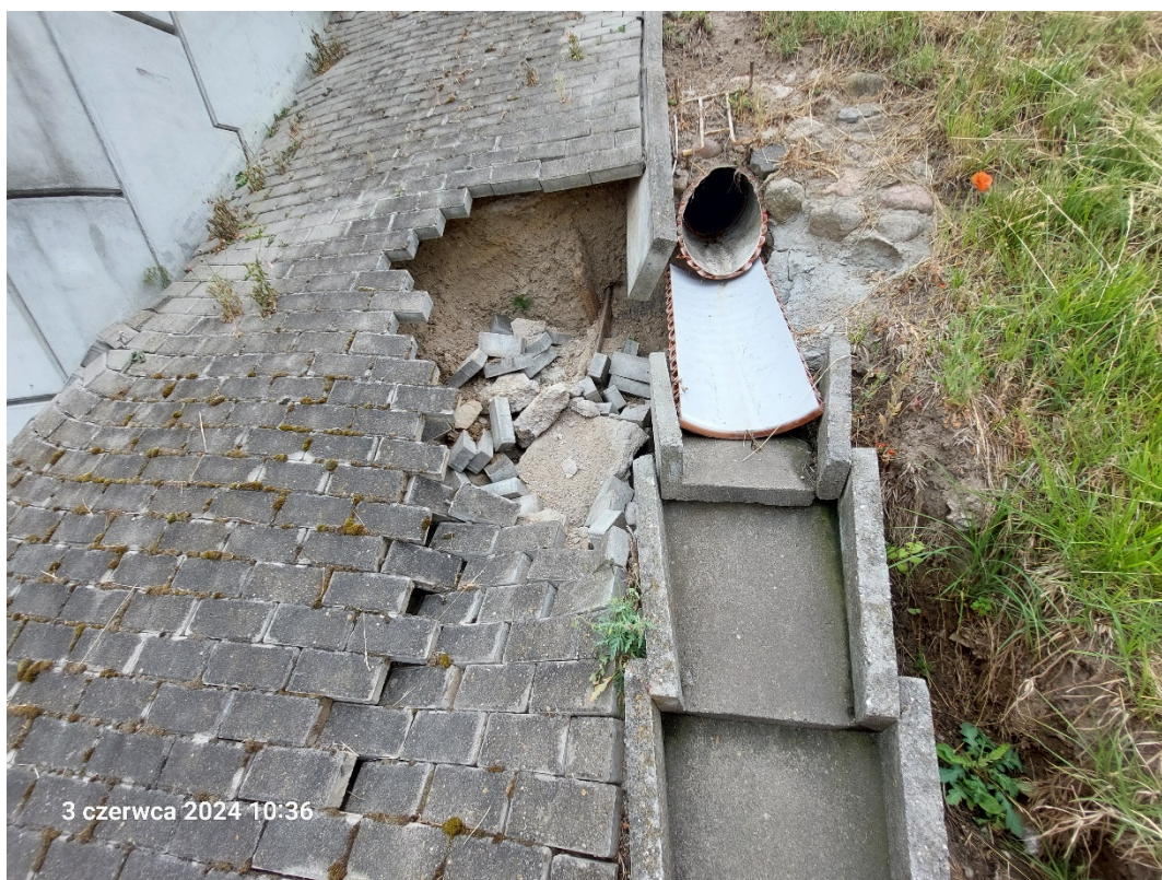
Fot. 2. – Uszkodzona skarpa.
