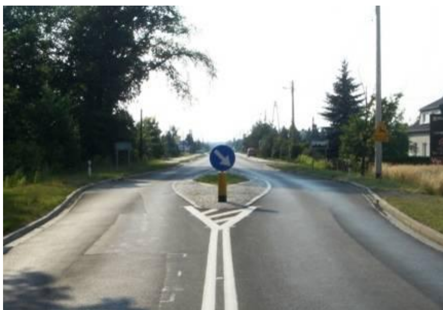
Fot. 3.1. Przykład „bramy wjazdowej” do obszaru zabudowanego – odgięcie toru jazdy wymuszające spowolnienie
