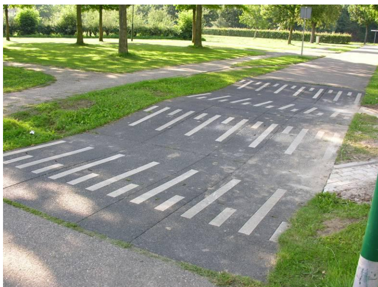
Fot. 4.26. Powierzchnia spowalniająca na drodze dla rowerów
