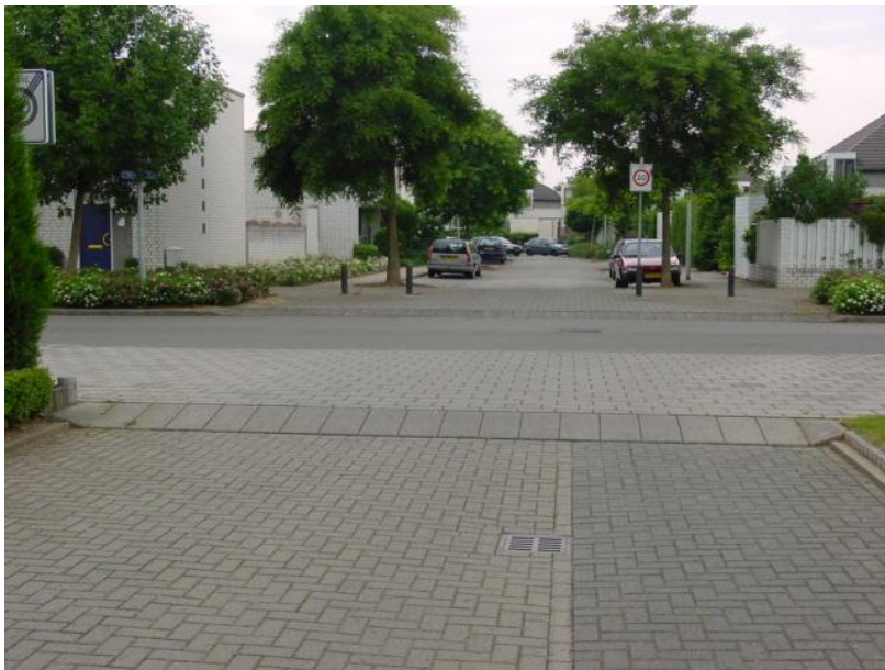
Fot. 4.19. Geometria wyjazdu ze strefy „30”. Chodnik poprowadzony w jednym poziomie wzdłuż drogi zbiorczej (50 km/h) wymusza spowolnienie ruchu na wlocie do skrzyżowania
