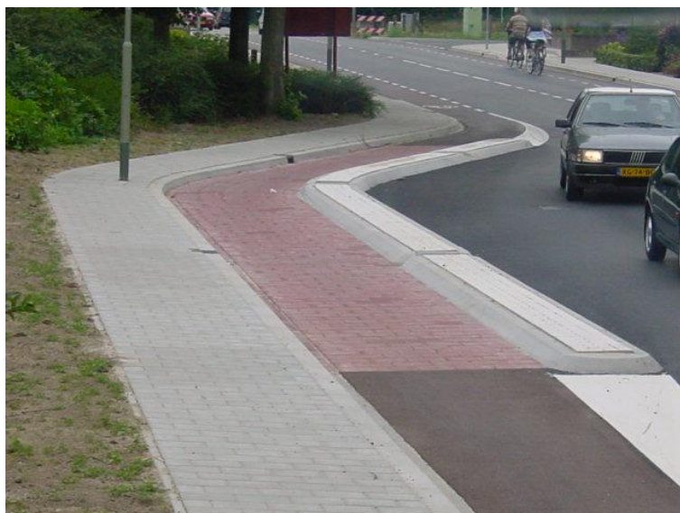
Fot. 4.24. Odgięcie drogi rowerowej na dojeździe do przejścia dla pieszych
