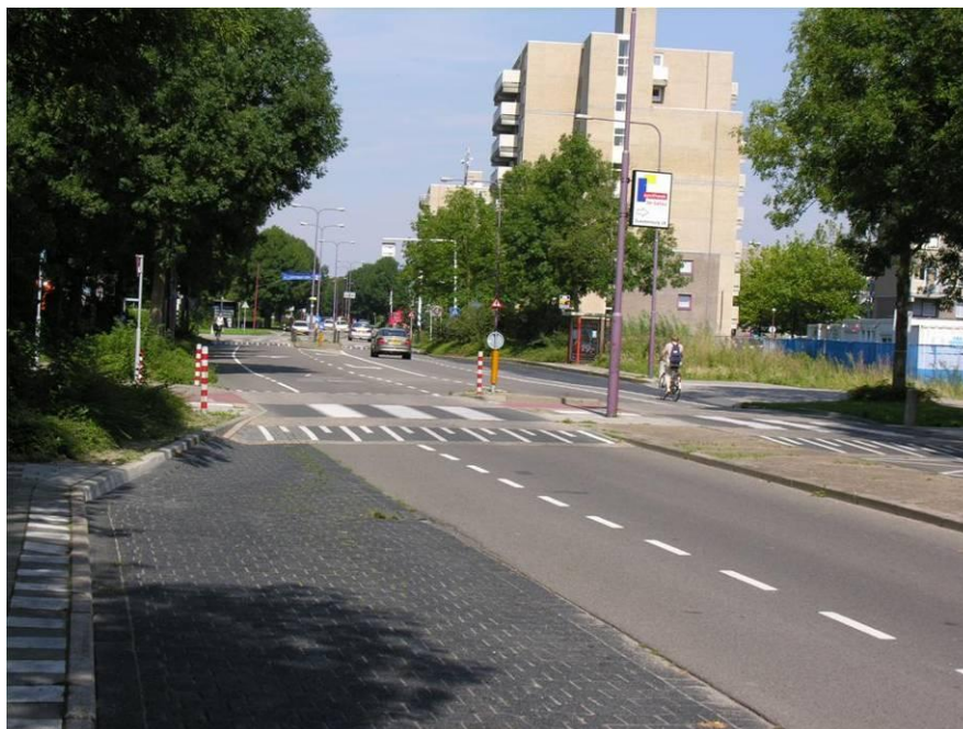
Fot. 3.10. Przykład prowadzenia ciągów pieszych w jednym poziomie dzięki wyniesionej powierzchni przejścia dla pieszych
