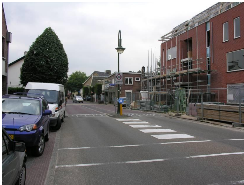
Fot. 4.17. Zmiana przekroju drogi na granicy stref o różnej prędkości dopuszczalnej
