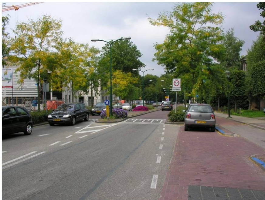
Fot. 3.5. Zmiana przekroju drogi na granicy stref o różnej prędkości dopuszczalnej
