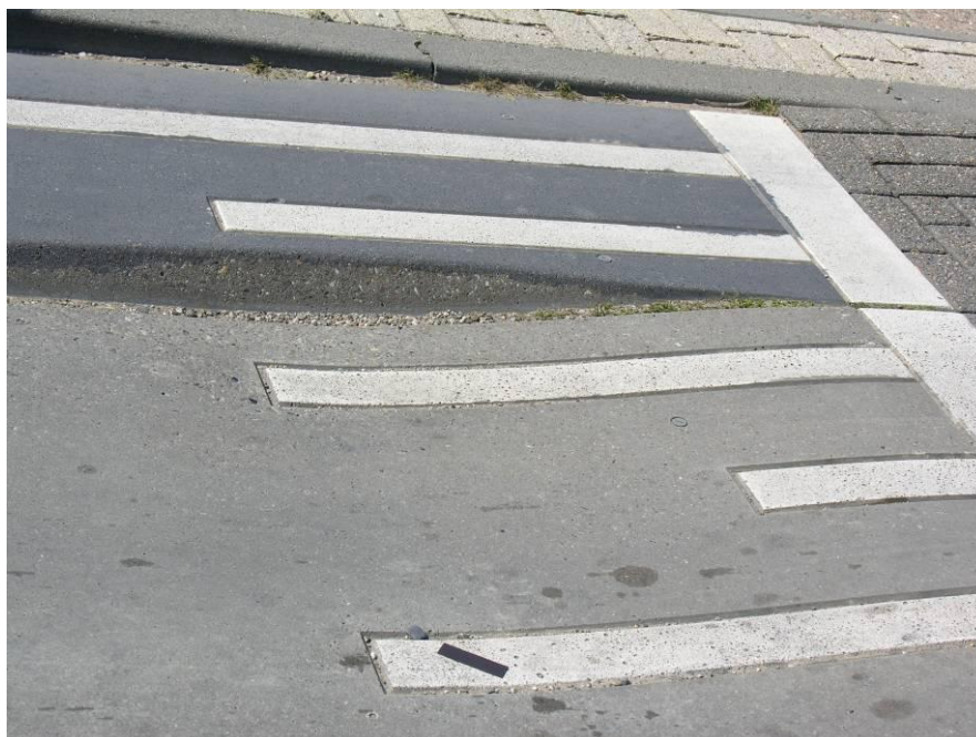
Fot. 4.4. Najazd na powierzchnię spowalniającą o zmiennym przekroju, dostosowanym do różnych rodzajów pojazdów
