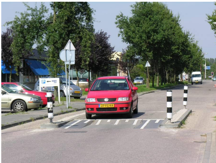
Fot. 4.3. Zawężenie przekroju drogi z powierzchnią spowalniającą. Przejazd pojazdów jednośladowych możliwy w jednym poziomie
