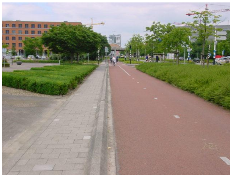
Fot. 4.23. Dwukierunkowa droga rowerowa odseparowana od jezdni (pas zieleni) i chodnika (separator ruchu)
