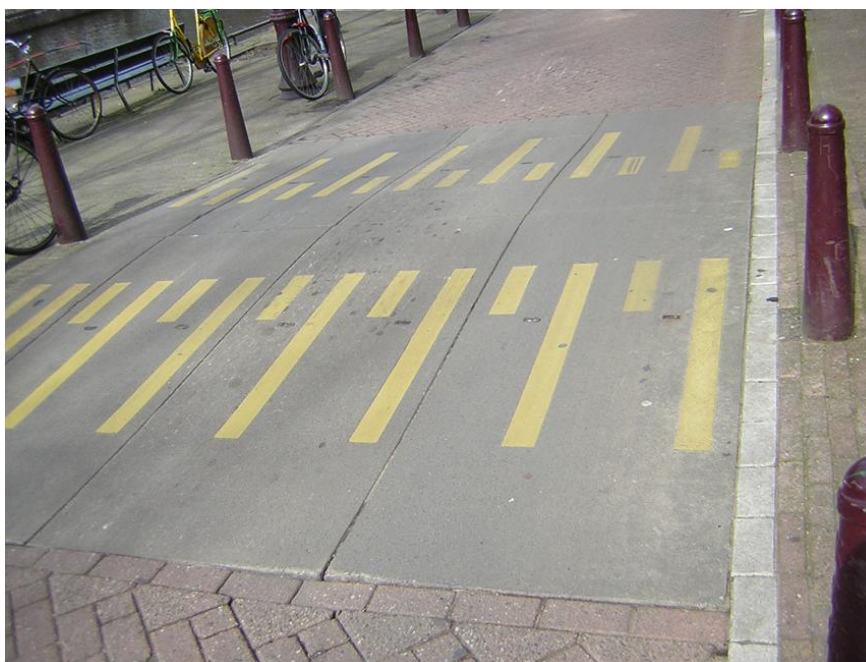
Fot. 4.1. Typowy prefabrykowany próg zwalniający stosowany w Holandii
