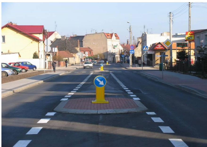
Fot. 4.11. Wykorzystanie środkowej części jezdni o przekroju trzypasowym do obsługi posesji
