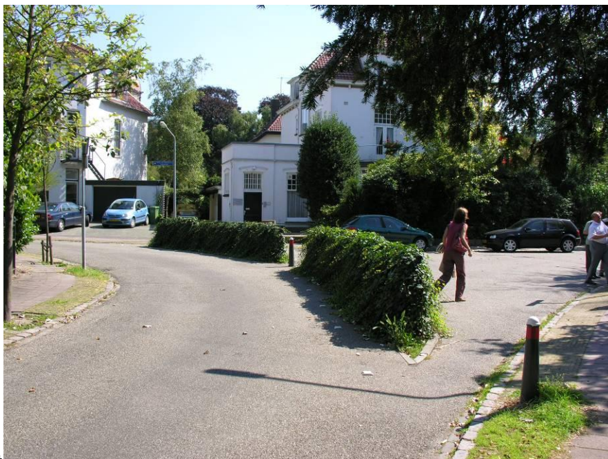
Fot. 4.15. Ograniczenie dostępności do obszaru pojazdom wielosiodowym. Żywopłot kryje w sobie solidną konstrukcję metalową.
