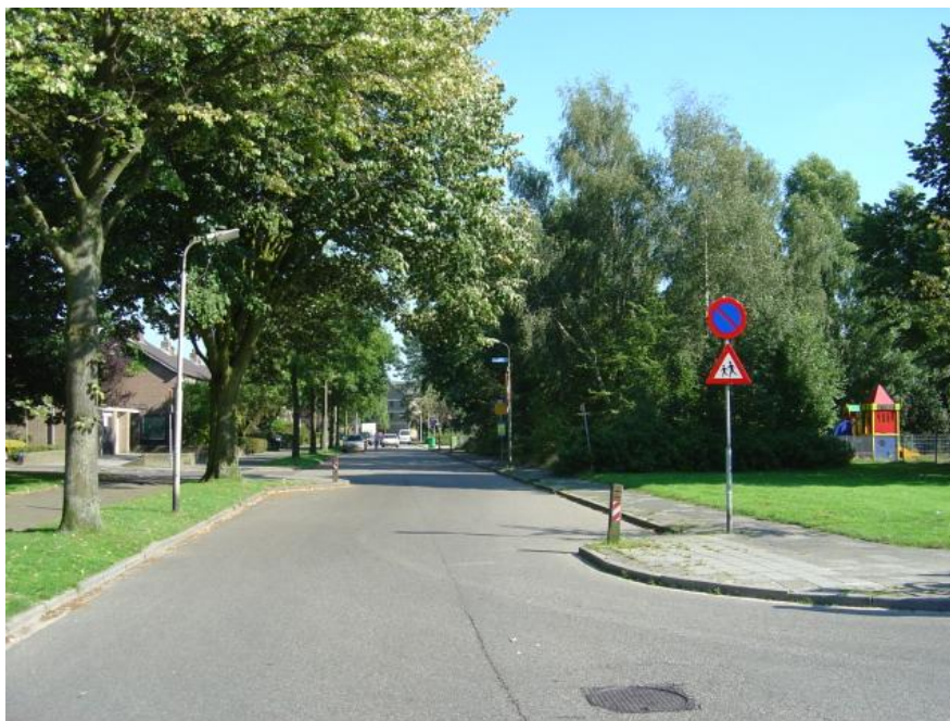
Fot. 4.8. Efekt spowolnienia ruchu na drodze z przyległą zabudową mieszkalną uzyskany poprzez odpowiednie ukształtowanie osi drogi
