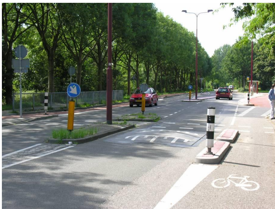
Fot. 4.5. Powierzchnia spowalniająca w postaci tzw. „poduszki”
