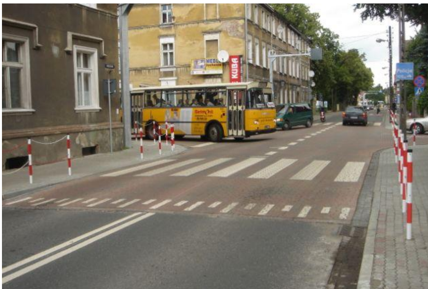
Fot. 3.8. Wyniesiona powierzchnia skrzyżowania w ciągu drogi pełniącej funkcję rozprowadzającą
