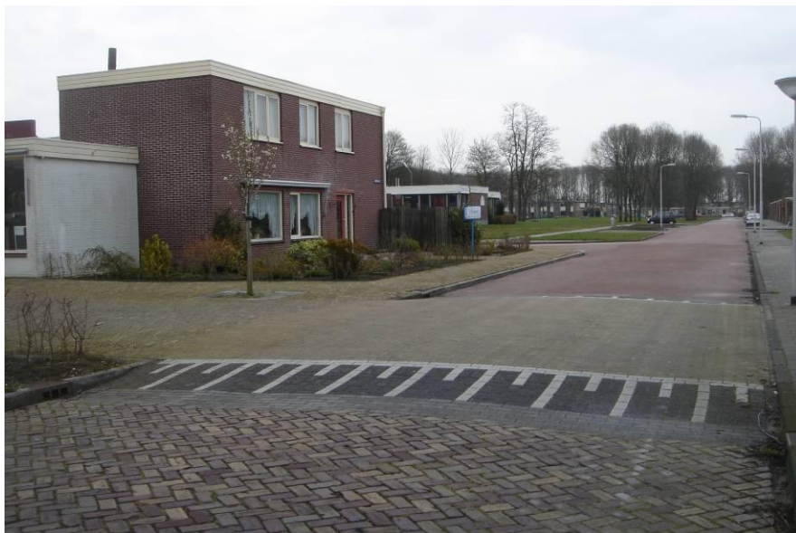
Fot. 4.2. Powierzchnia spowalniająca z najazdami w postaci progów typu „A” w strefie „30”. Oznakowanie pionowe nie jest w tym przypadku wymagane
