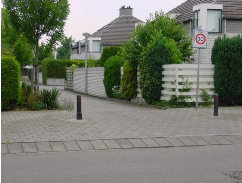
Fot. 4.18. Zjazd do strefy „30” na skrzyżowaniu. Ciąg pieszy wzdłuż drogi zbiorczej (50 km/h) prowadzony w jednym poziomie
