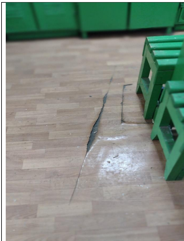
Pomieszczenie szatni dla pracowników
