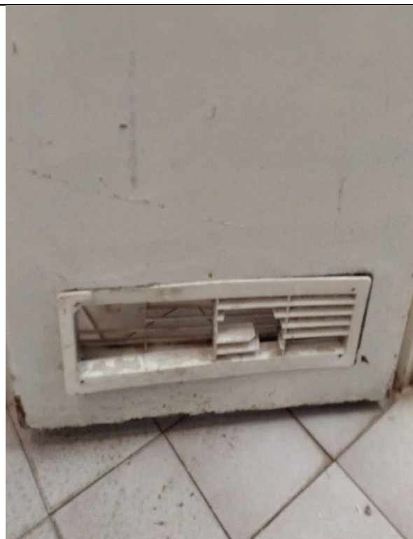
Zniszczone drzwi wejściowe do pomieszczenia toalety
