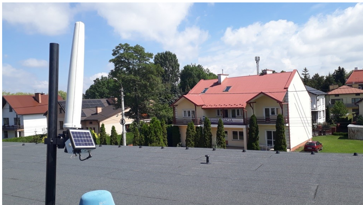
Rys. 2 Miejsce montażu SMS PEM – Szkoła Podstawowa nr 1 w Mielcu
