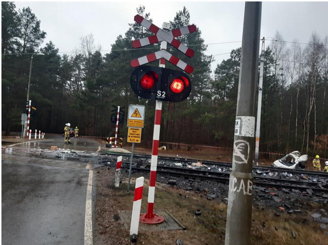
Zdjęcie 8 - Widok ogólny miejsca zdarzenia (materiał komisji kolejowej)
