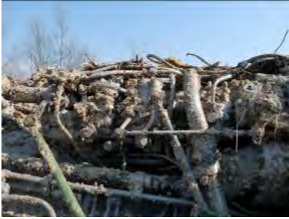
Zdj. 55. Widok agregatów silnikowych oraz elementów sterowania silnikiem – noniusz na pompie NR-30KU-4
