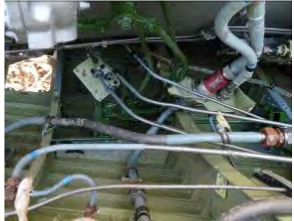
Zdj. 36. Widok elementów sterowania silnikiem
