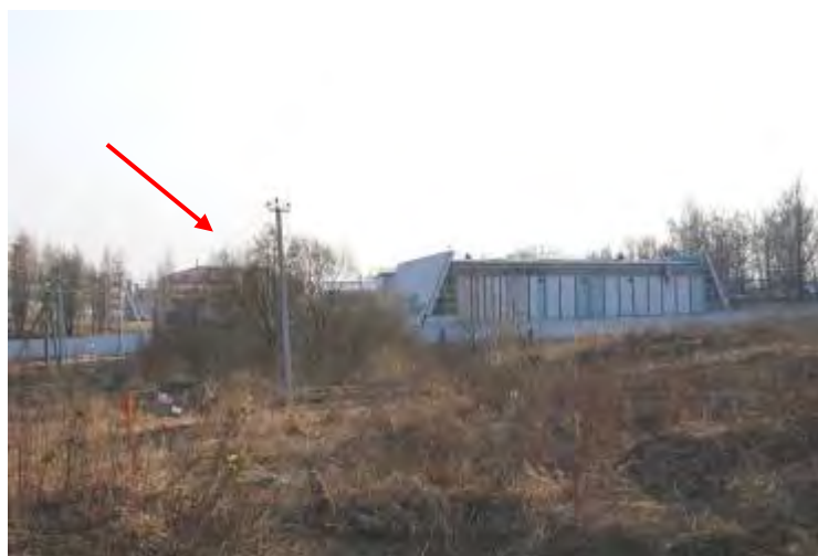
Rys. 9. Zerwane przewody linii energetycznej (punkt 7 rys. 2)
