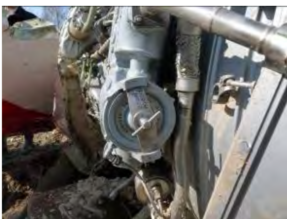
Zdj. 21. Widok filtra na chłodnicy paliwowo-olejowej
