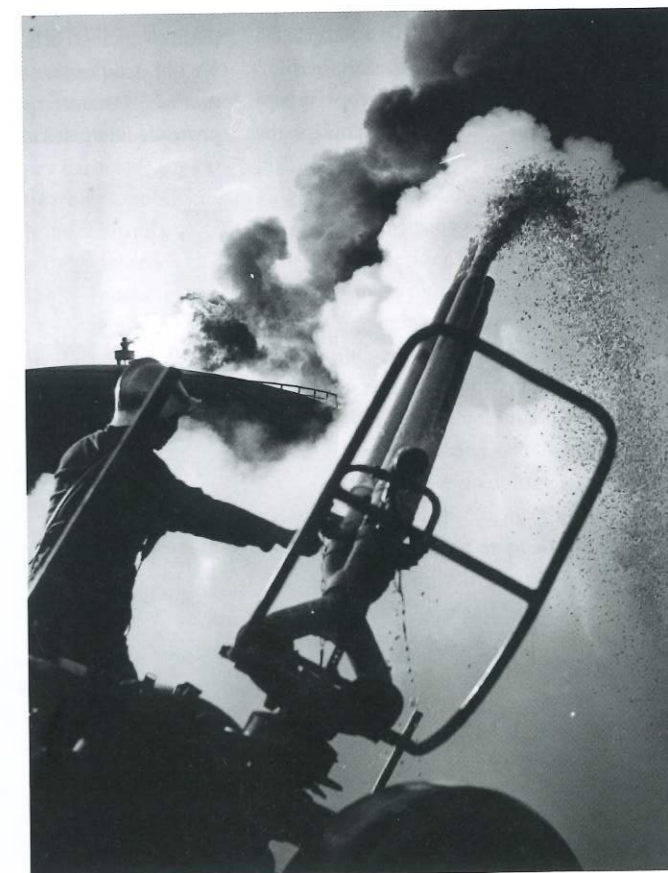
Podawanie piany ciężkiej z działka szwedzkiego na tacę zbiornika nr 253 arch. CMP w Mysłowicach
