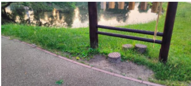
Powierzchnia ścieżki przed drewnianym stelażem.
