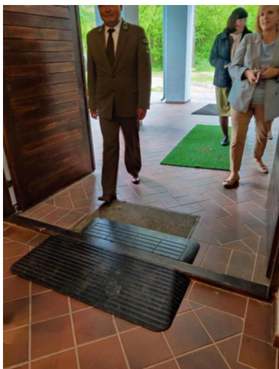
Gumowy niwelator progu w wejściu do budynku.
