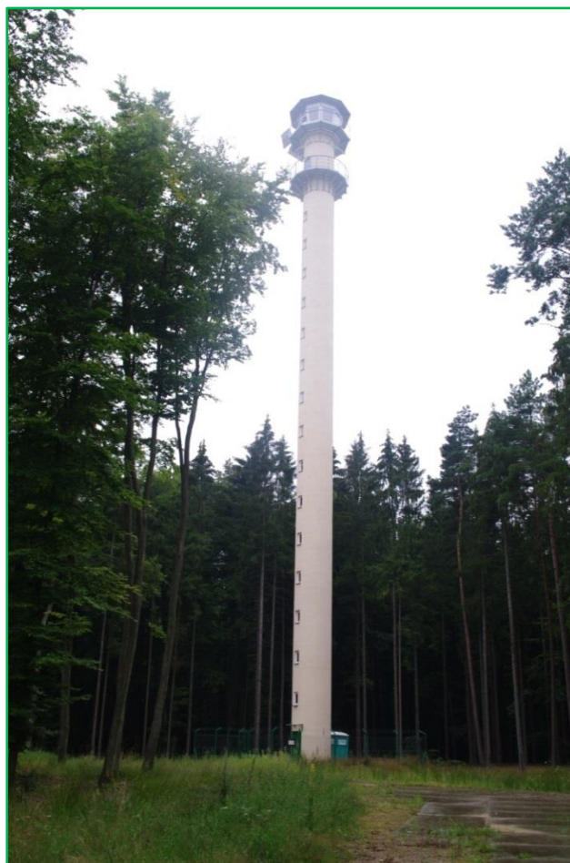
Wieża p-poż. oddz. 342k (obręb Żukowo)
