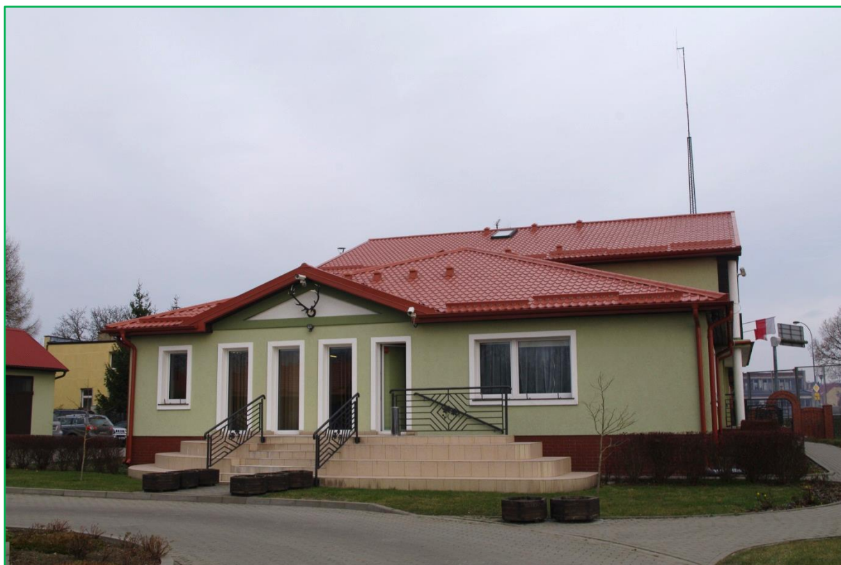
Siedziba N-ctwa Sławno, oddz. 84i (obręb Żukowo)
