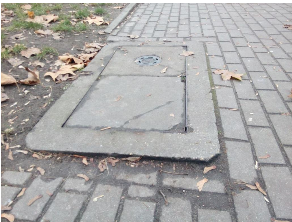
Rys. 6.8. Wyniesione urządzenia obce
