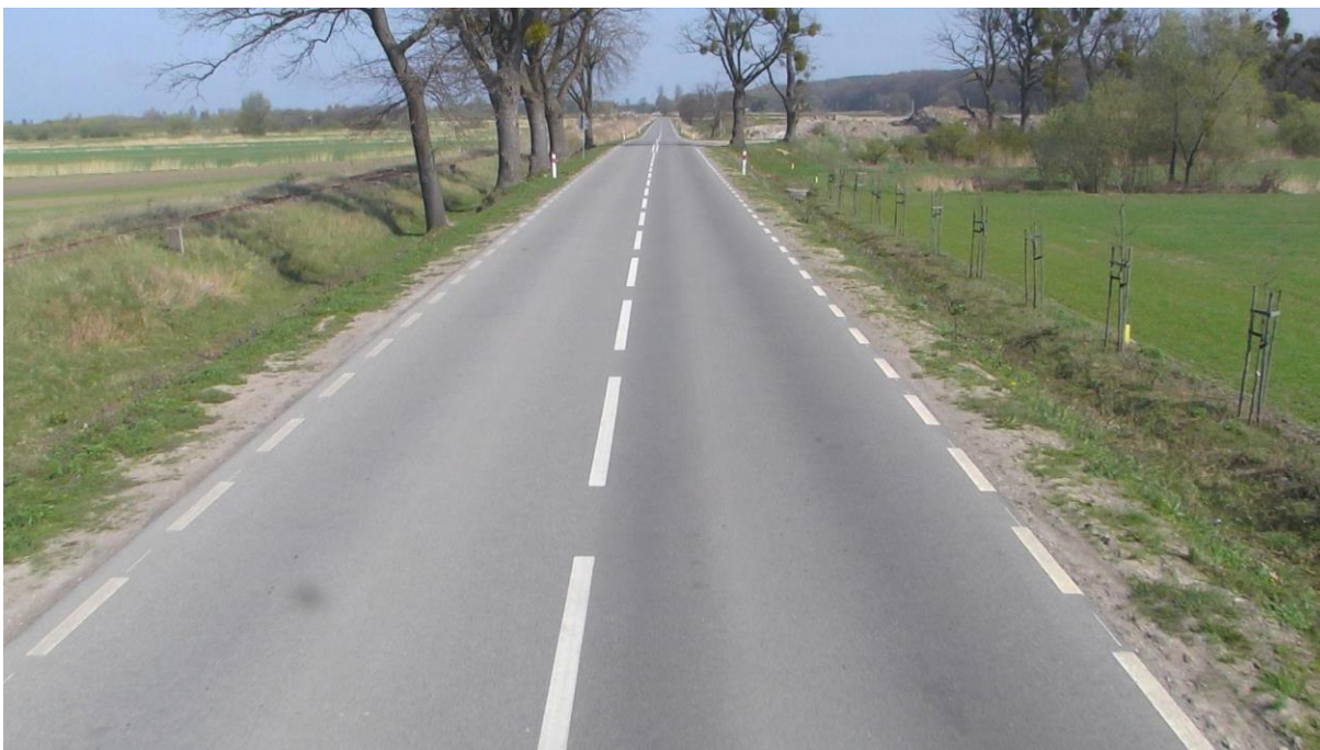
Rys. 4.5.3.2. Przykładowe zdjęcie pasa drogowego wykonane kamerą frontową
