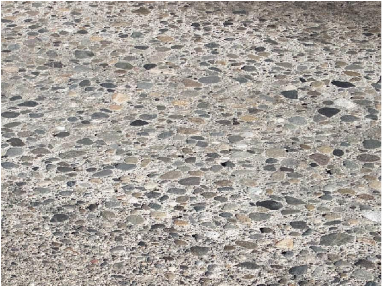
Rys. 5.2.3.1. Widok wypolerowanej powierzchni płyty
