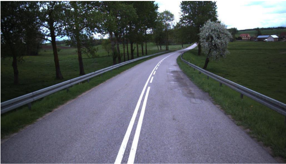
Rys. 5.1.3.5. Stan niezadawalający: łaty zajmujące do 20% powierzchni [3]
