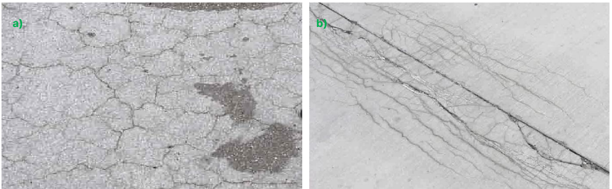
Rys. 5.2.3.2. Widok pęknięć mrozowych: a) w postaci nieregularnej siatki; b) przy krawędzi płyty
