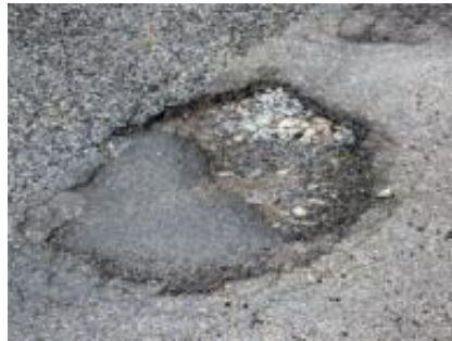
Rys. 5.1.3.2. Łaty: o nieregularnym i regularnym kształcie [3]
