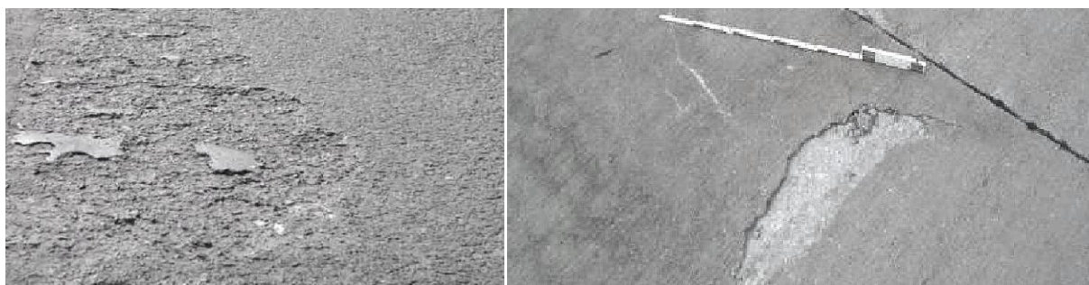
Rys. 5.2.3.7.1. Widok złuszczeń
