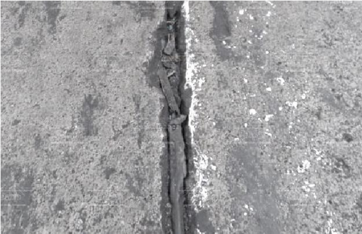
Rys. 5.2.4.4. Widok uszkodzenia wypełnień w szczelinie
