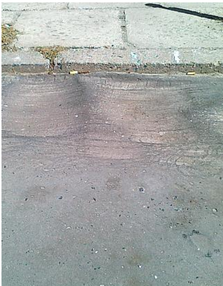
Rys. 5.1.1.3. Deformacje trwałe – odciski
