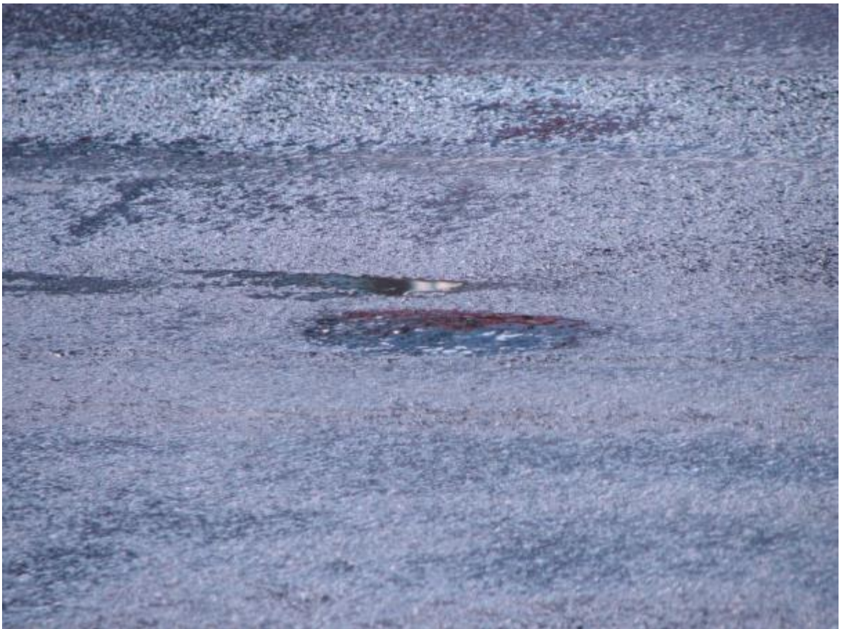
Rys. 5.1.3.8. Wyptyw (plamy) lepiscza
