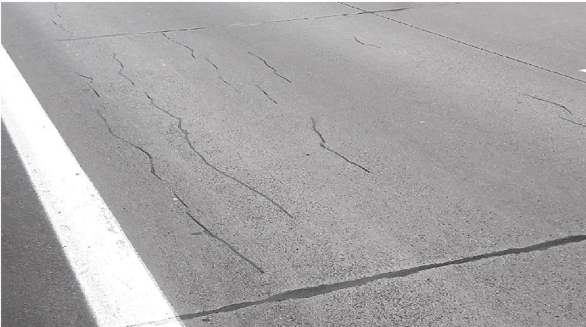
Rys. 5.2.2.2. Widok krótkich pęknięć podłużnych
