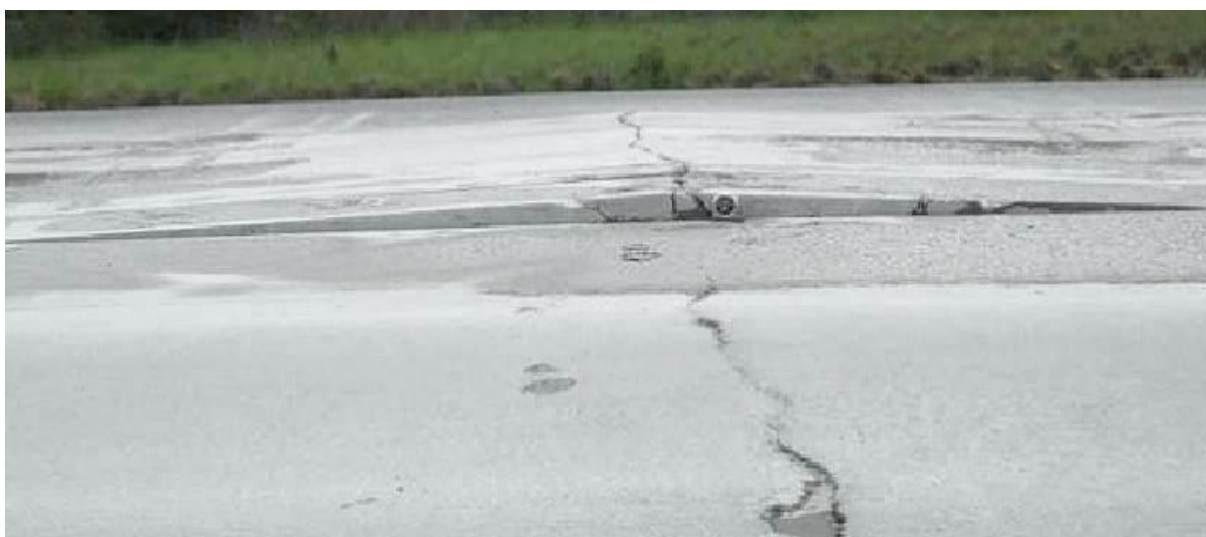
Rys. 5.2.1.4. Widok deформacji podłużnych na długości płyty
