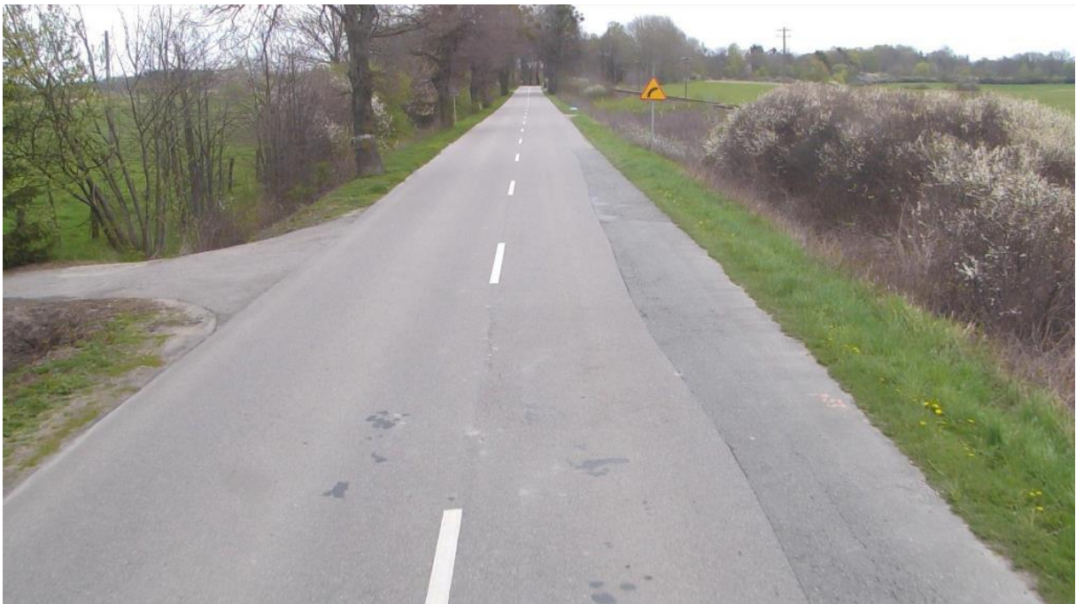
Rys. 5.1.3.4. Stan niezadawalający: łaty zajmujące do 20% powierzchni [3]
