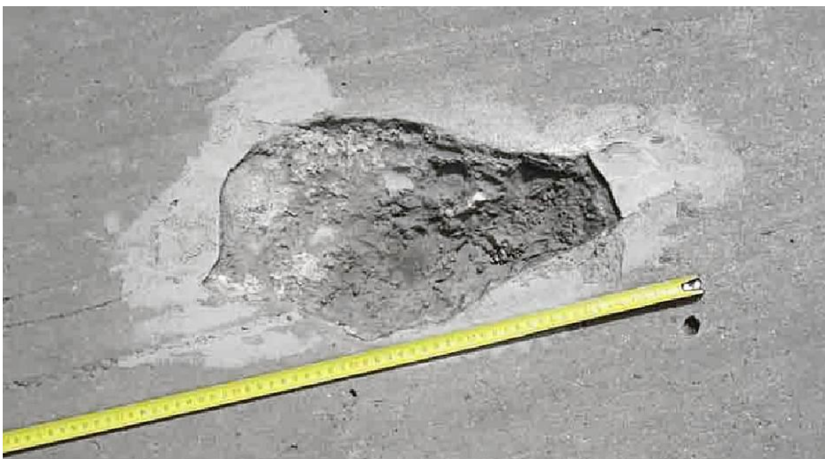
Rys. 5.2.3.8. Widok wyboju
