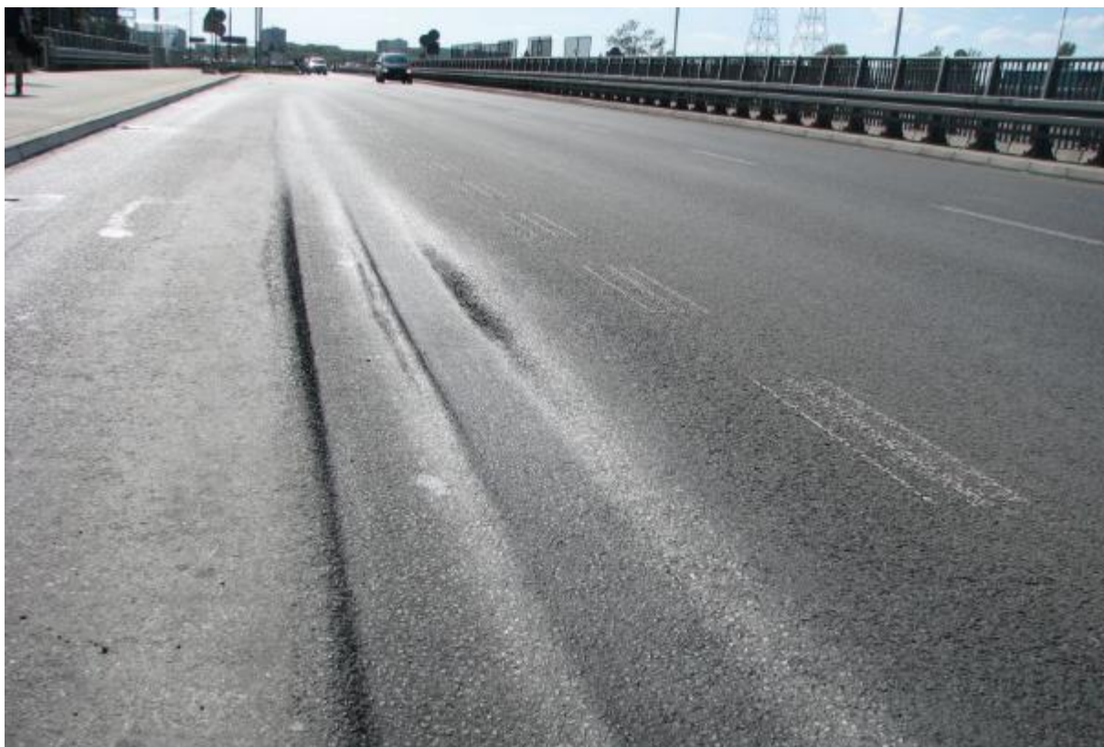
Rys. 5.1.1.1. Koleiny lepkoplastyczne
