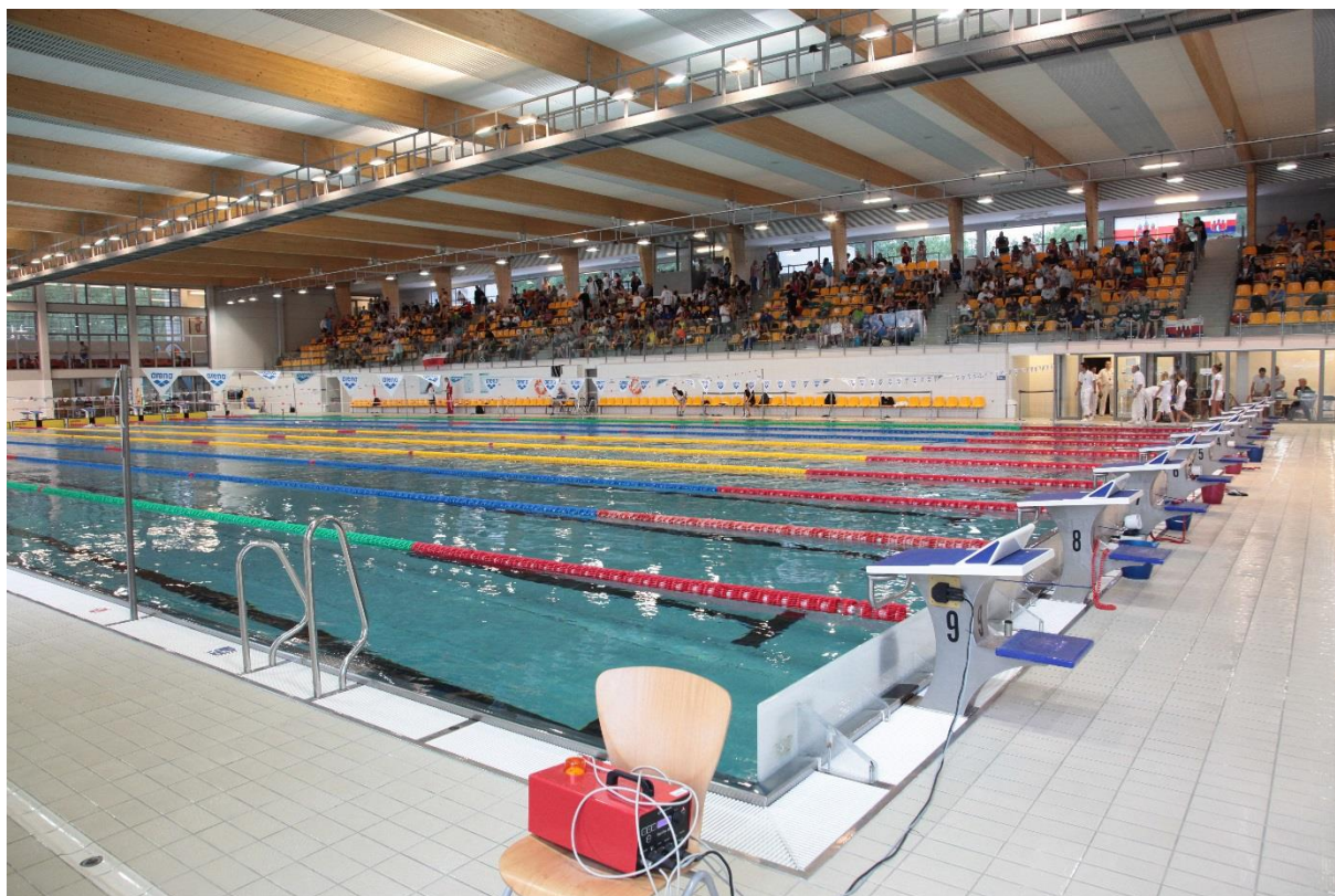
Fot. 4 Niecka basenu pływalni olimpijskiej w Gliwicach
