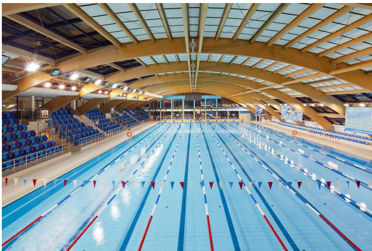
Fot. 17 Niecka basenu pływalni olimpijskiej w Warszawie - Warszawianka
