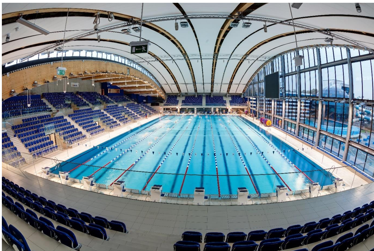
Fot. 7 Niecka basenu pływalni olimpijskiej w Lublinie
