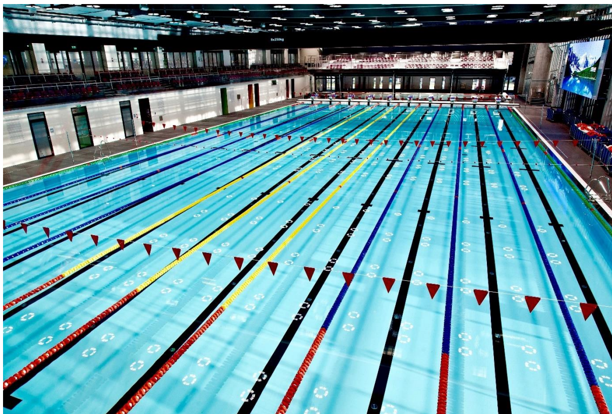
Fot. 15 Niecka basenu pływalni olimpijskiej w Warszawie - WUM
