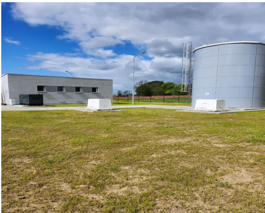
Fot. 1. – Wodociąg w Młynkowie
