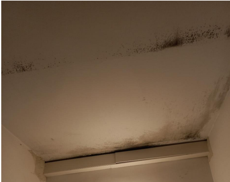
Fot. 4.– Pomieszczenie socjalne (GZK w Lubaszu)
