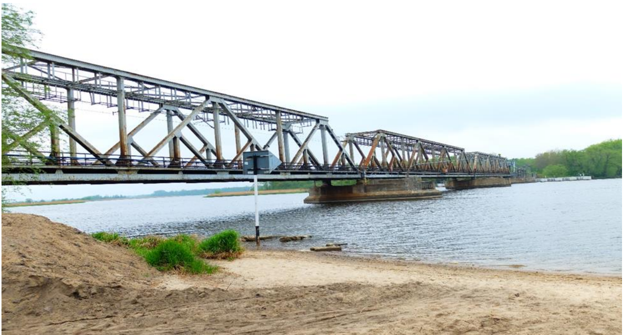
Zdjęcie nr 1: Istniejący most kolejowy
