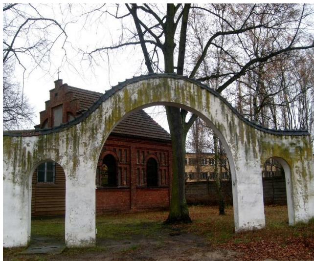
Rys. nr 2 Kaplica cmentarna z 1892 roku przy ulicy Chocimskiej;
