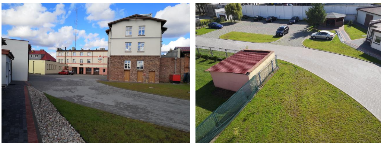
Fot. 22 Modernizacja placu w KP PSP w Pucku.
