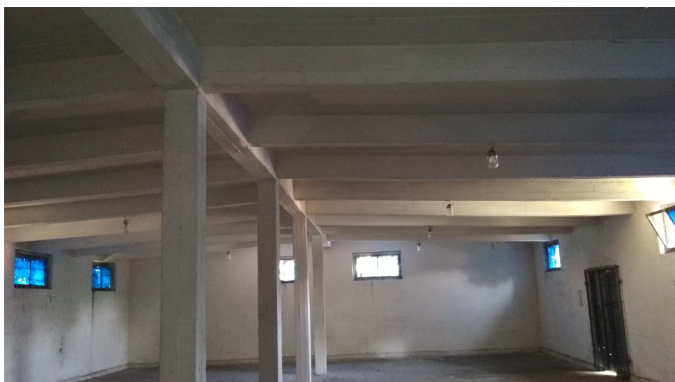
Fot.6 Konstrukcja stropodachu.
