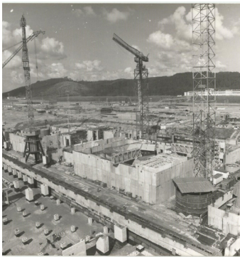
Fot. 1. Budowa EJ Żarnowiec (fot. Stanisław Wiesiołowski).
