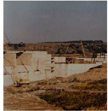
Fot. 11. Budowa instalacji zrzutu wody chłodzącej w EJ Kursk w ZSRR (obecnie Rosja) w latach 80-tych. Prace budowlane realizowało polskie przedsiębiorstwo Energopol (fot. Energopol-Warszawa).
