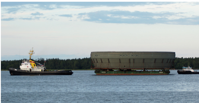
Fot. 18. Zdjęcie przedstawiające transport okładziny z portu w Gdyni do Olkiluoto w Finlandii (na plac budowy) (fot. TVO/Hannu Huovila)
