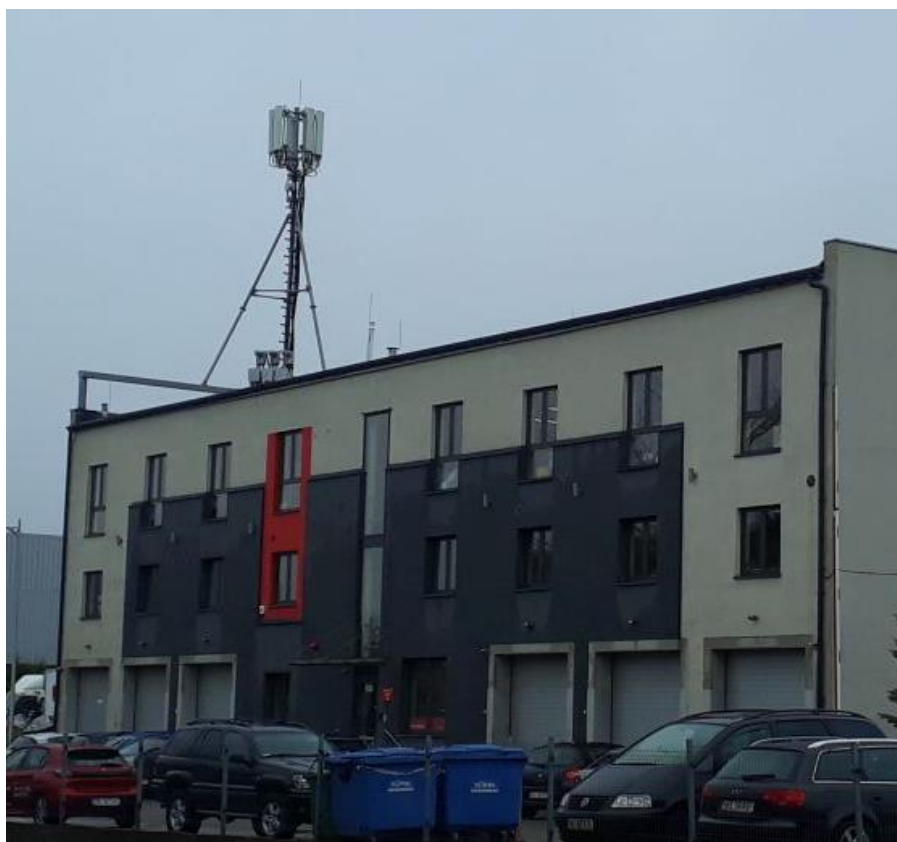
Fot. 1: Widok anten stacji bazowej: ID: OLS1058_A, zlokalizowanej pod adresem: ul. Leonharda 5A, 10-454 Olsztyn
