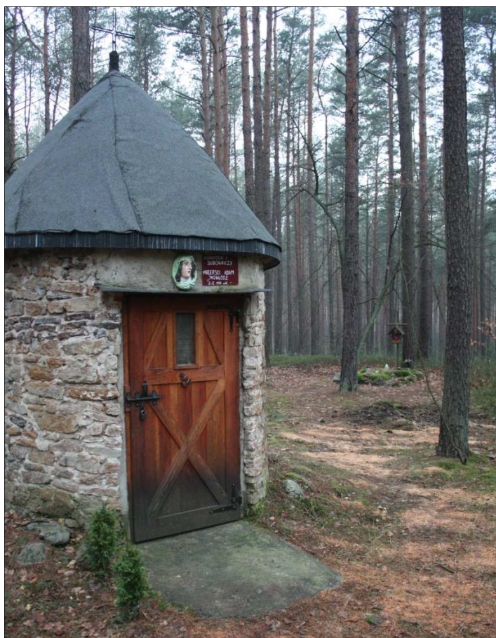
Fot. 31. Kapliczka murowana z okresu powstań narodowych - inne nazwy: Kapliczka Giełzów, Pustelnia Giełzów (fot. Michał Potocki).
