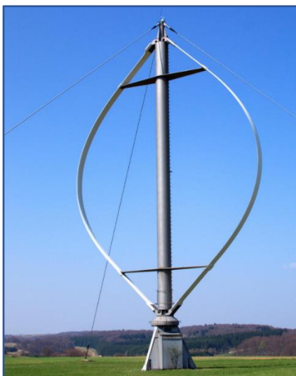
fot. 9 instsani: turbina Darrieusa (o osi pionowej)
