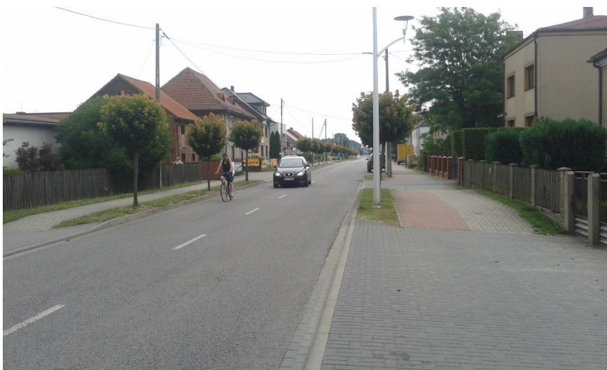
Fot. 12. Ciasna, RB4. Badany odcinek ul. Zjednoczenia w kierunku skrzyżowania z ul. mjr. Hubala.
