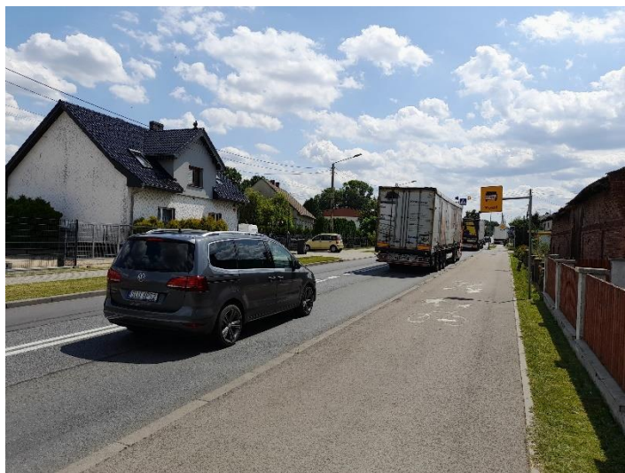
Fot. 6. Glinica, RB2. Badany odcinek ul. Asfaltowej (DK11) w kierunku Lublińca.
