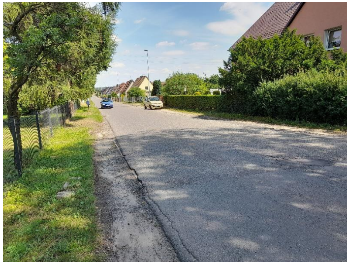
Fot. 8. Panoszów, RB3. Badany odcinek ul. Ceramicznej w kierunku skrzyżowania z ul. Szkolną.
