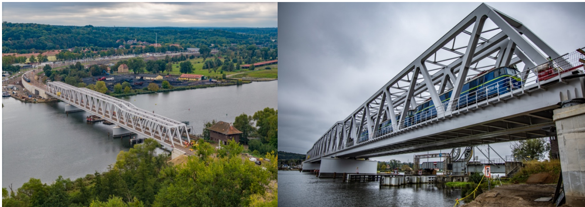
Fot. numer 1 i numer 2: Poglądowe zdjęcia po zakończeniu inwestycji
