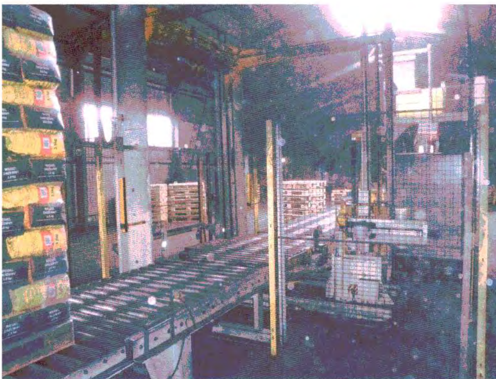
Rys. 11. Widok urządzeń do rozważania, pakowania i formowania palet węgla drzewnego, Uherce Mineralne, gm. Olszanica; stan z dnia 4 marca 2014 r. [4]
