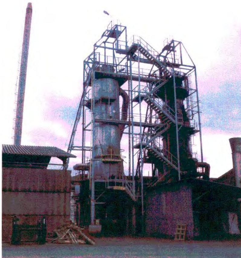
Rys. 8. Stacjonarna instalacja do produkcji węgla drzewnego w miejscowości Uherce Mineralne, eksploatowana przez Spółkę EXTRANS w Sanoku, Uherce Mineralne, gm. Olszanica; stan z dnia 4 marca 2014 r. [4]
