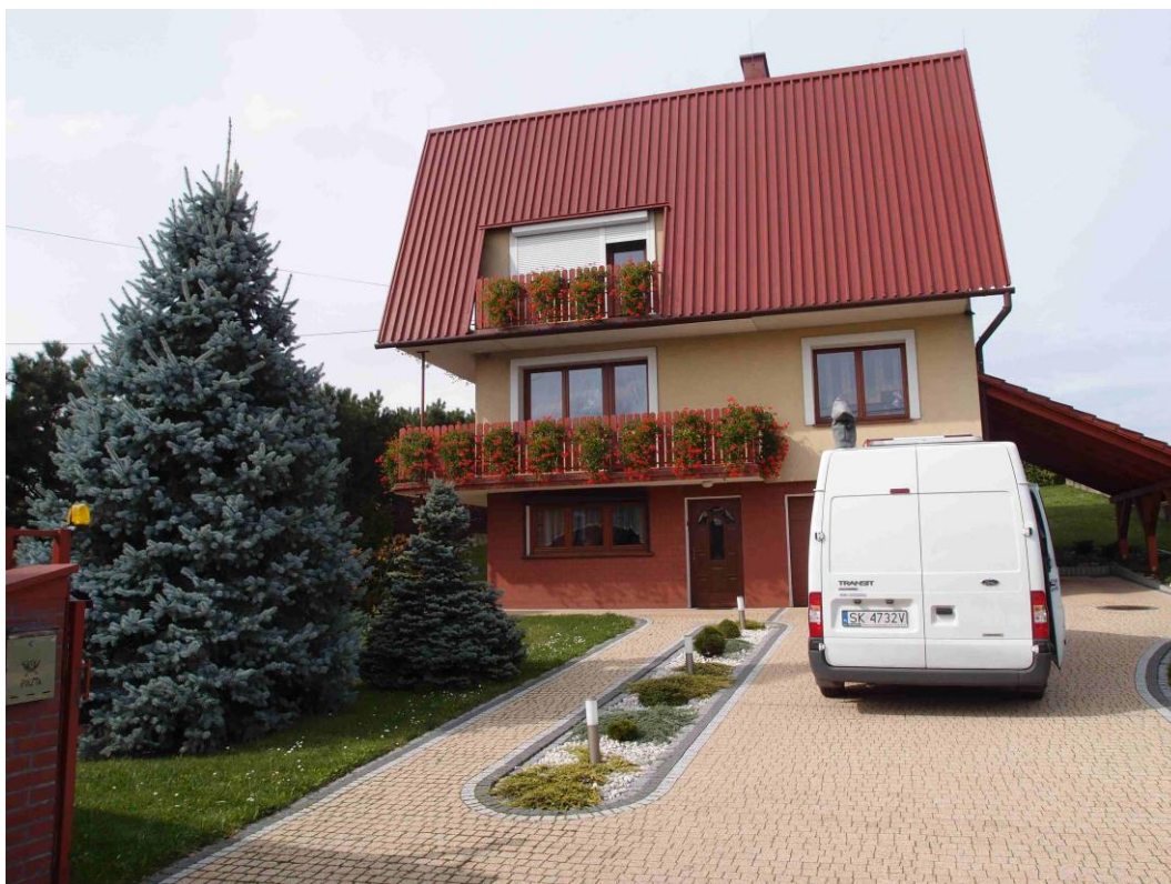
Fot. 2. Pisarzowice. Budynek przy którym wykonano pomiar
