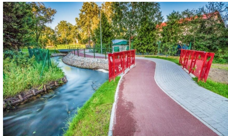
Ciąg pieszo-rowerowy wzdłuż Zagórskiej Strugi
