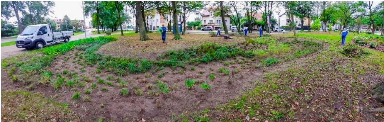
ul. Filtrowa system małej retencji - ogród deszczowy
