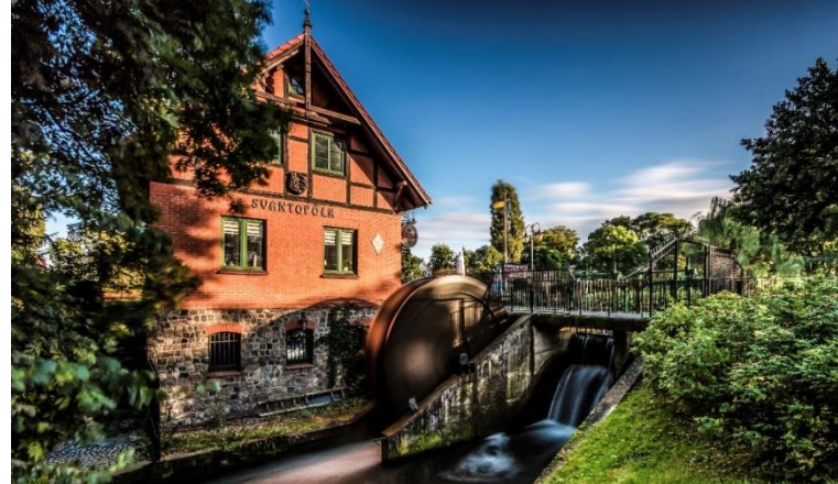
Zabytkowe urządzenia wodne przy Zagórskiej Strudze
