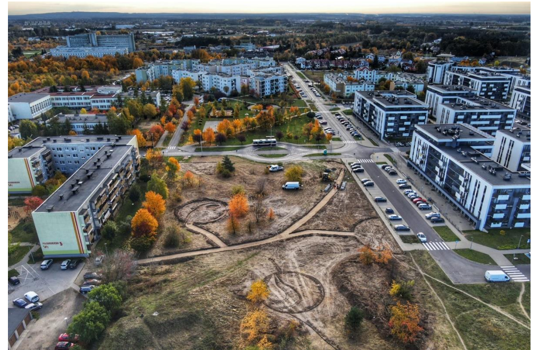
Teren objęty projektem w trakcie budowy, 2023 r.
