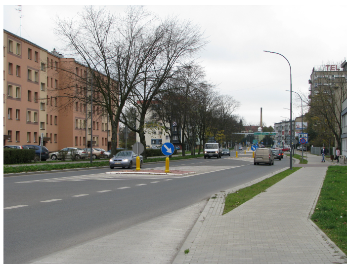
Fot. 14. Racibórz, RB5. Badany odcinek ul. Bosackiej (DW 935) w kierunku skrzyżowania z ul. Armii Krajowej
