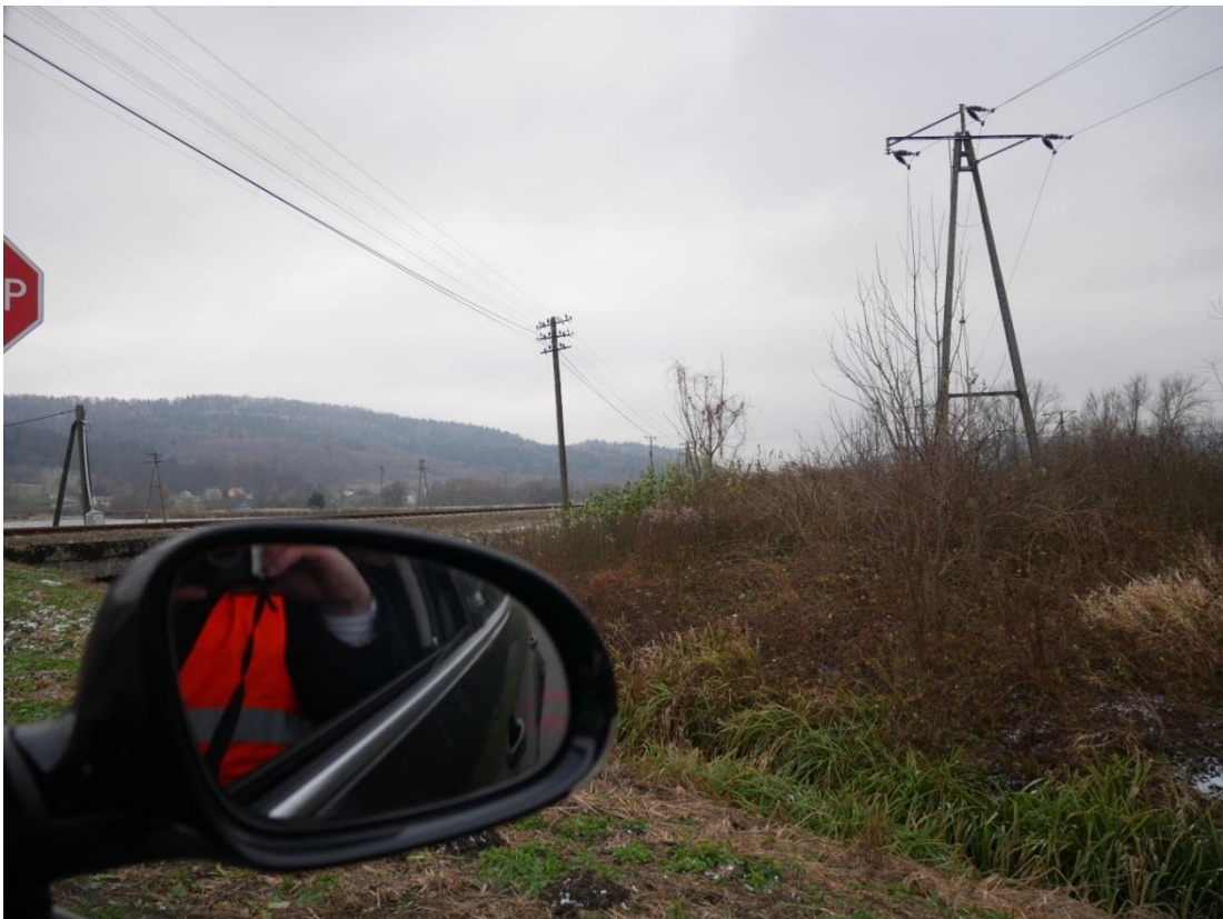
Fot. 1. – widoczność z 20 m (w stronę nadjeżdżającego pociągu)
