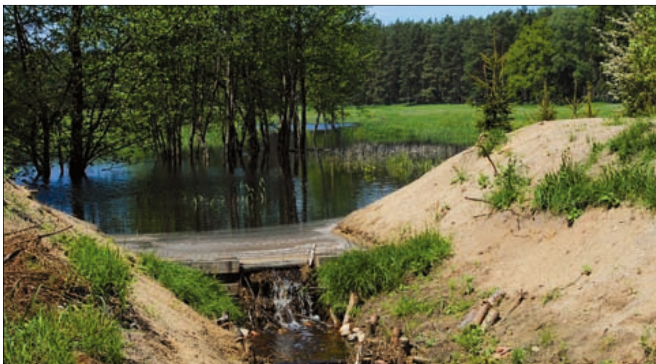
Fot. 8. Przykład zastawki spowalniającej odpływ wód z torfowiska
